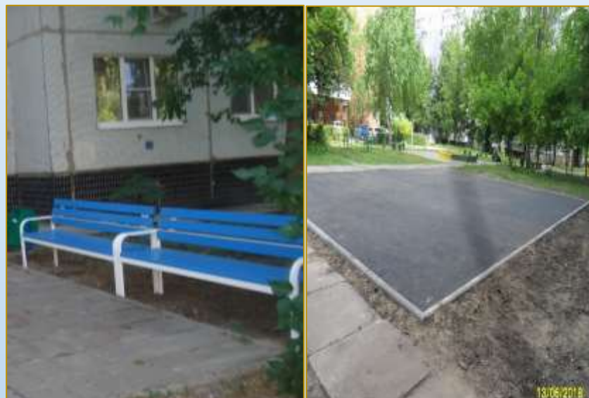
Фото объекта «В работе»
