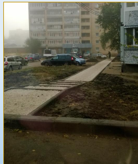
Фото объекта «В работе»
