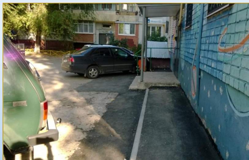
Фото объекта «В работе»
