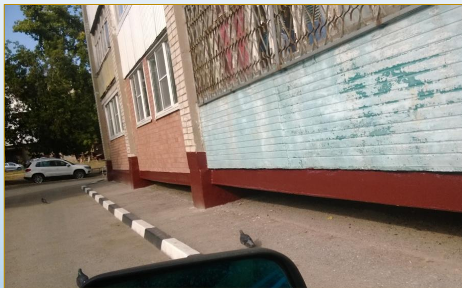
Фото объекта «После»
