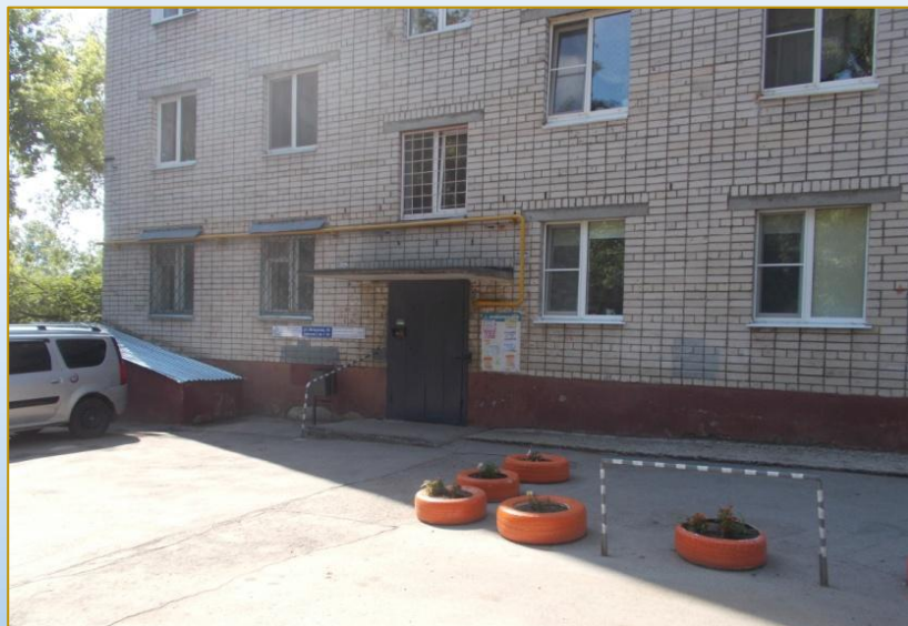
Фото объекта «До»
