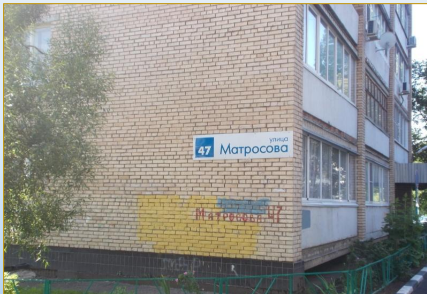
Фото объекта «До»
