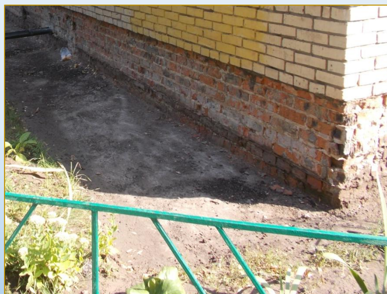
Фото объекта «В работе»
