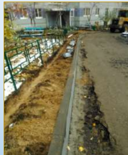
Фото объекта «В работе»
