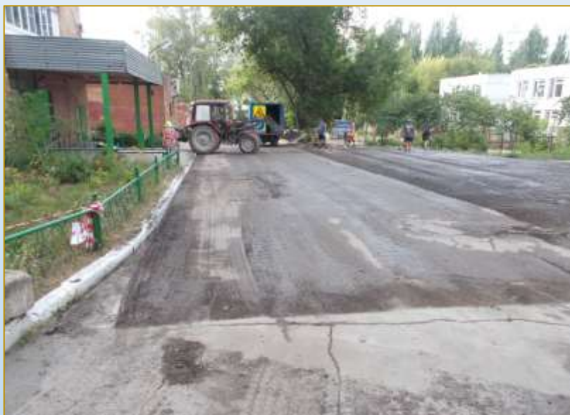
Фото объекта «В работе»
