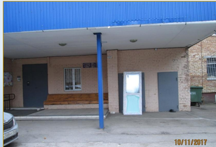
Фото объекта «В работе»
