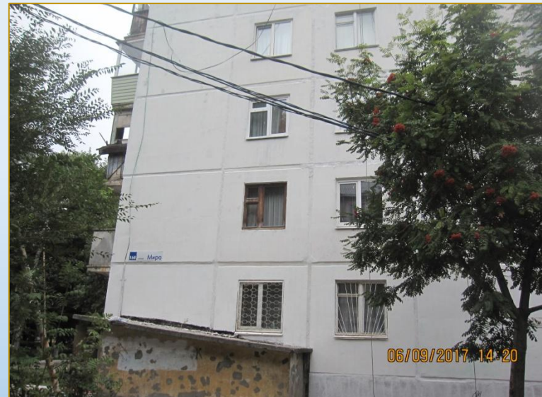
Фото объекта «В работе»
