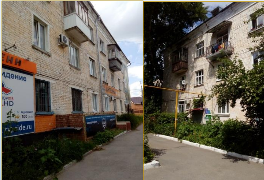
Фото объекта «До»
