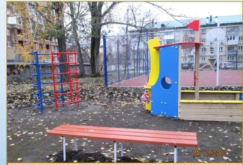
Фото объекта «После»
