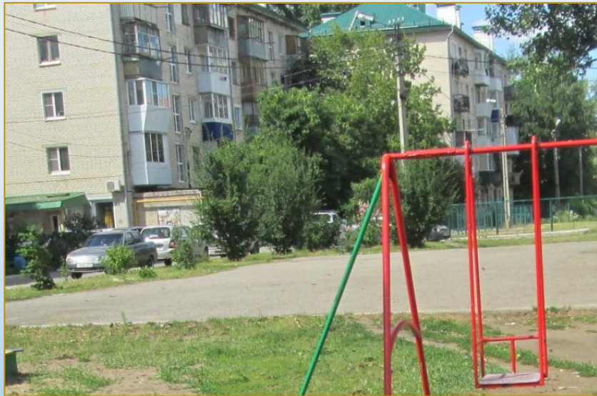
Фото объекта «До»
