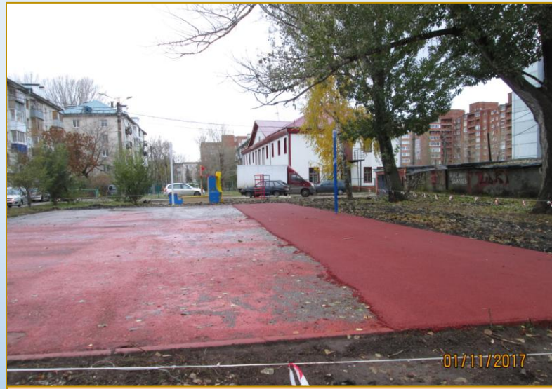
Фото объекта «В работе»
