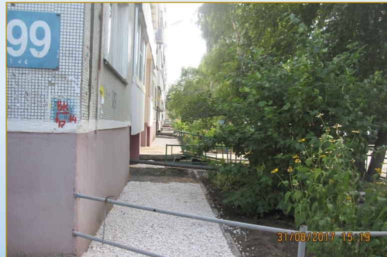
Фото объекта «В работе»
