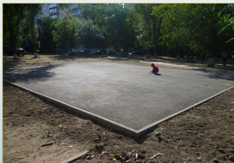
Фото объекта «В работе»
