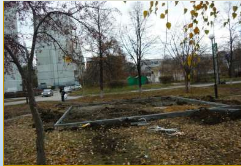
Фото объекта «В работе»
