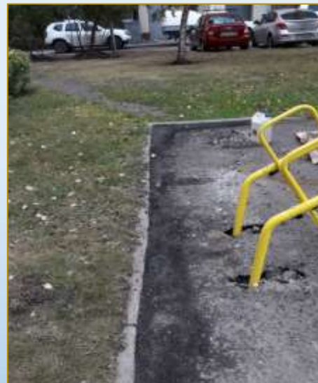
Фото объекта «В работе»
