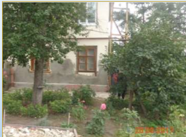
Фото объекта «В работе»
