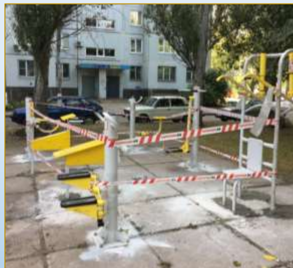
Фото объекта «В работе»
