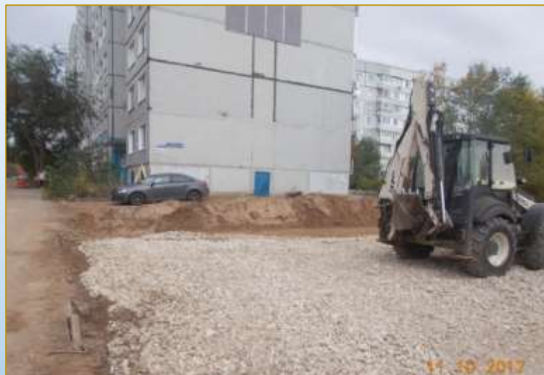
Фото объекта «В работе»
