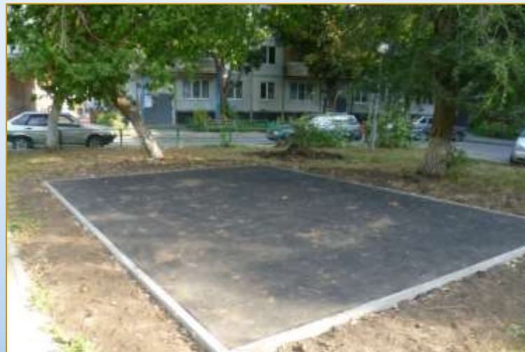
Фото объекта «В работе»
