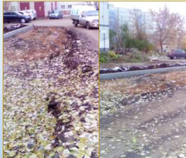
Фото объекта «В работе»
