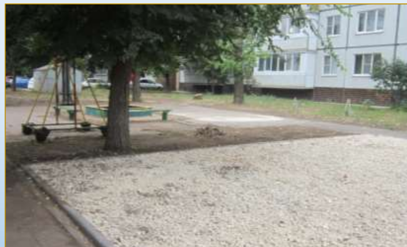
Фото объекта «В работе»
