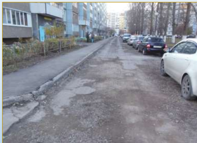
Фото объекта «В работе»
