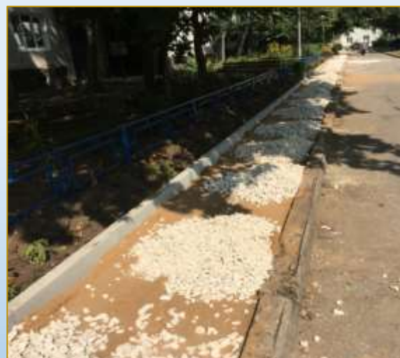
Фото объекта «В работе»
