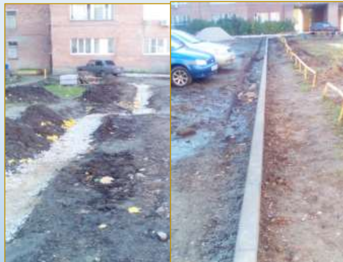
Фото объекта «В работе»
