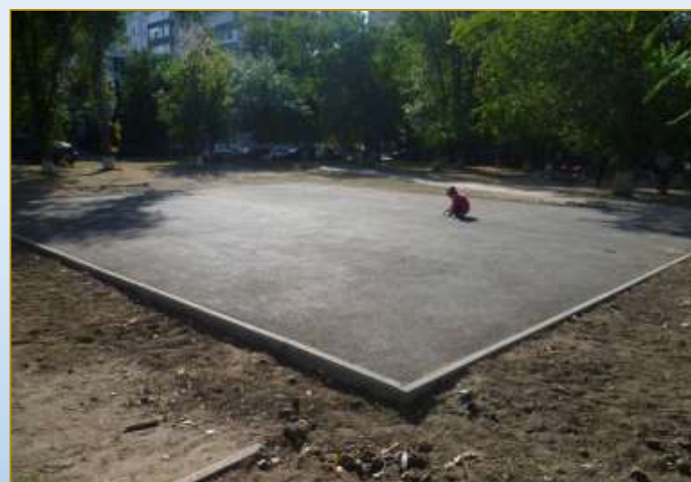
Фото объекта «В работе»
