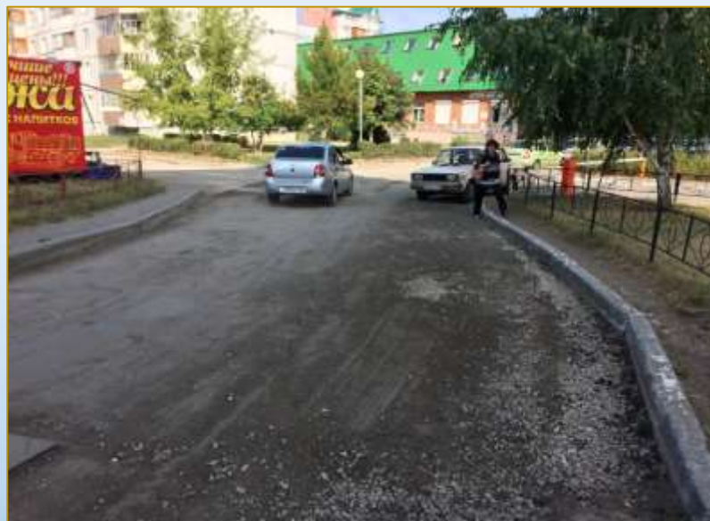
Фото объекта «В работе»
