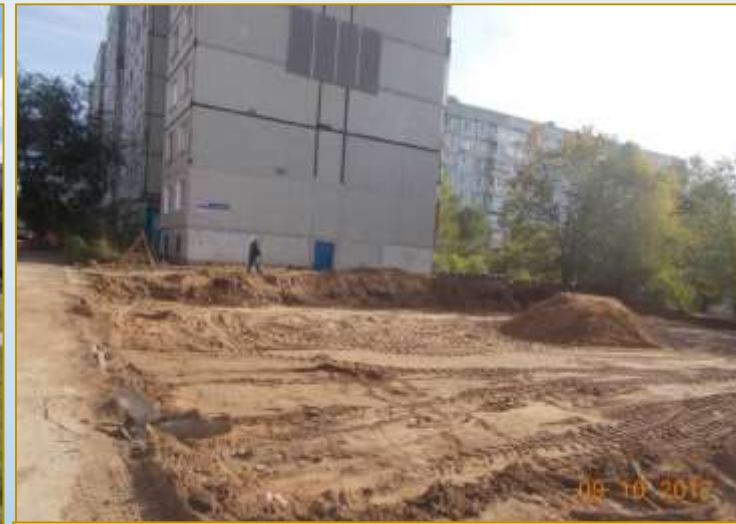
Фото объекта «В работе»
