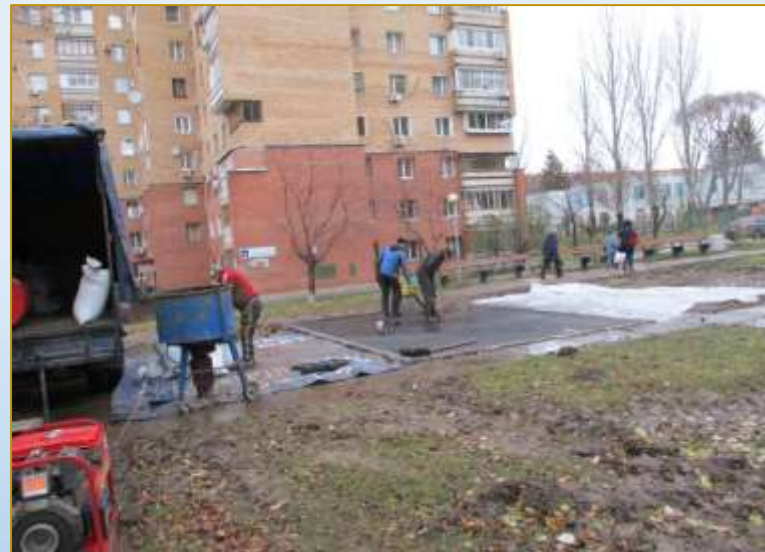
Фото объекта «В работе»
