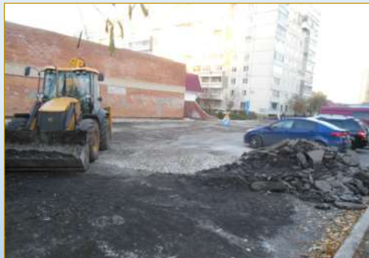
Фото объекта «В работе»
