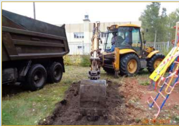
Фото объекта «В работе»
