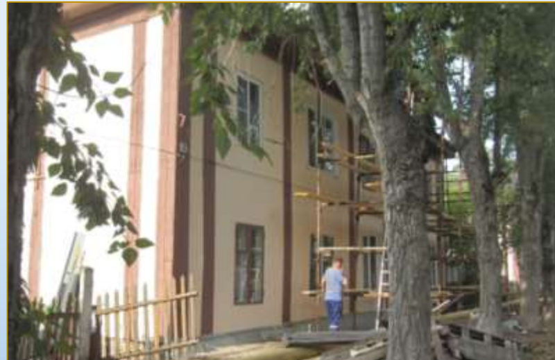
Фото объекта «В работе»
