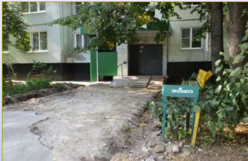
Фото объекта «В работе»
