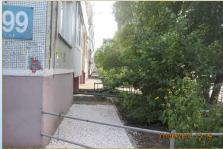
Фото объекта «В работе»
