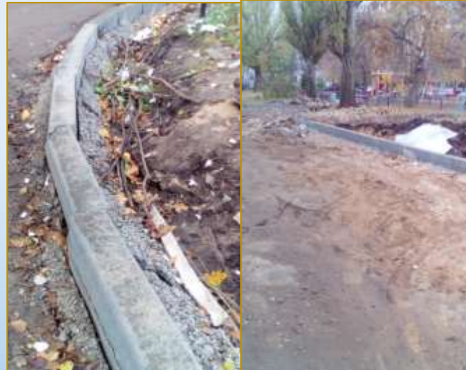
Фото объекта «В работе»
