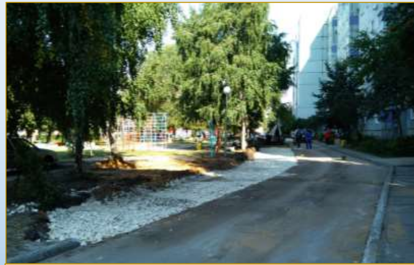
Фото объекта «В работе»
