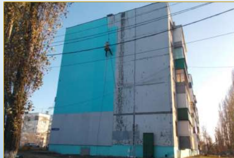
Фото объекта «В работе»
