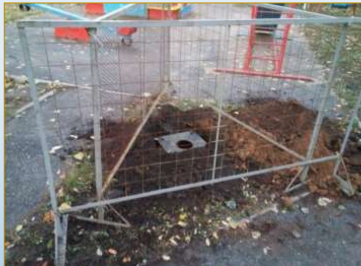
Фото объекта «В работе»
