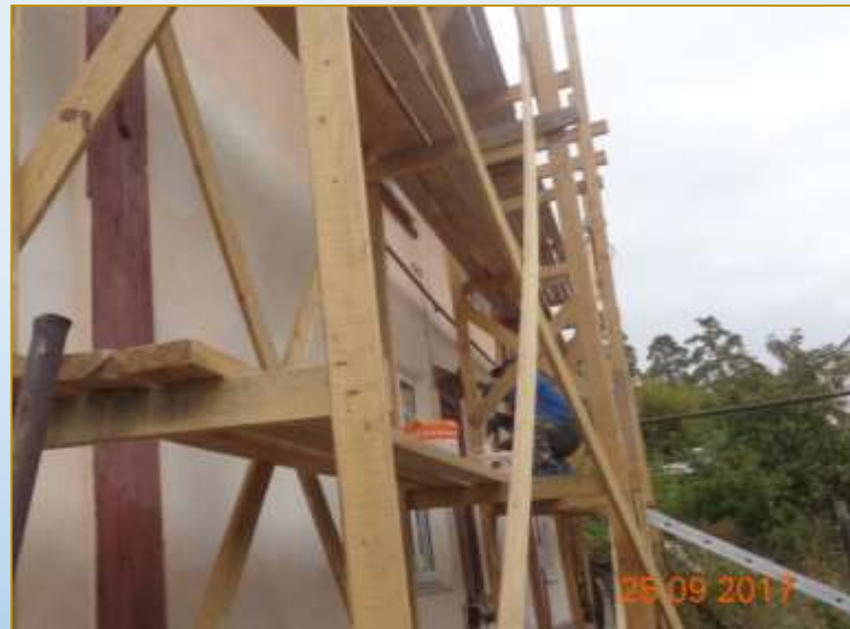
Фото объекта «В работе»
