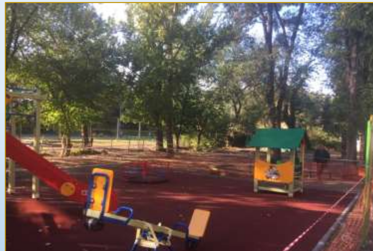
Фото объекта «В работе»
