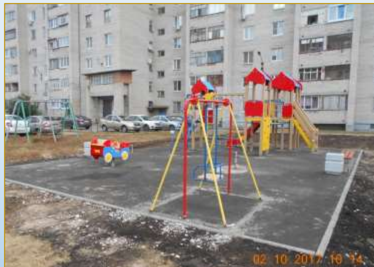
Фото объекта «В работе»
