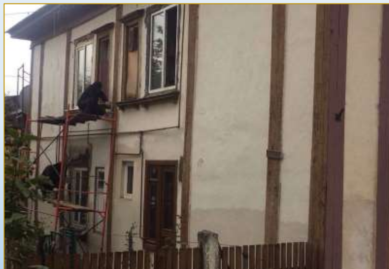
Фото объекта «В работе»
