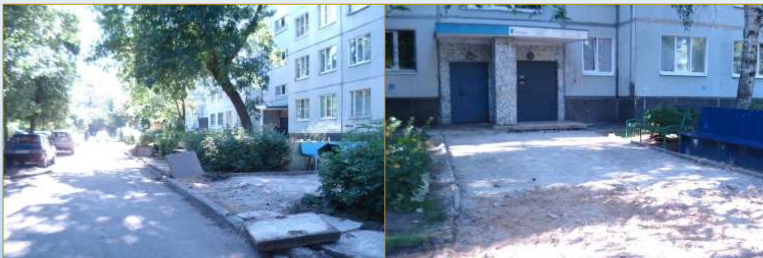
Фото объекта «В работе»
