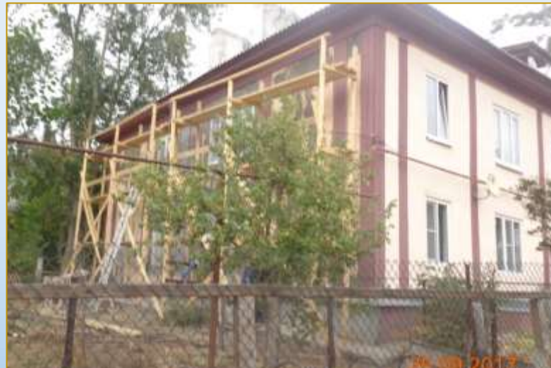
Фото объекта «В работе»
