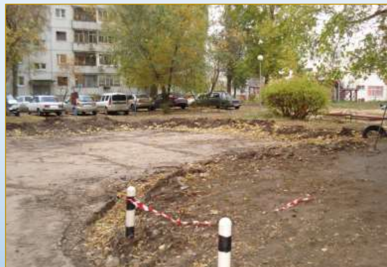
Фото объекта «В работе»
