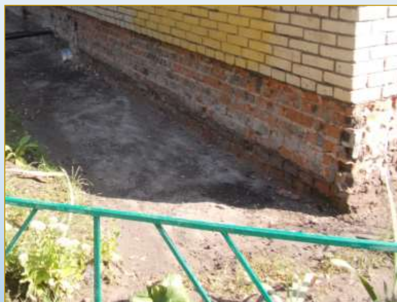
Фото объекта «В работе»
