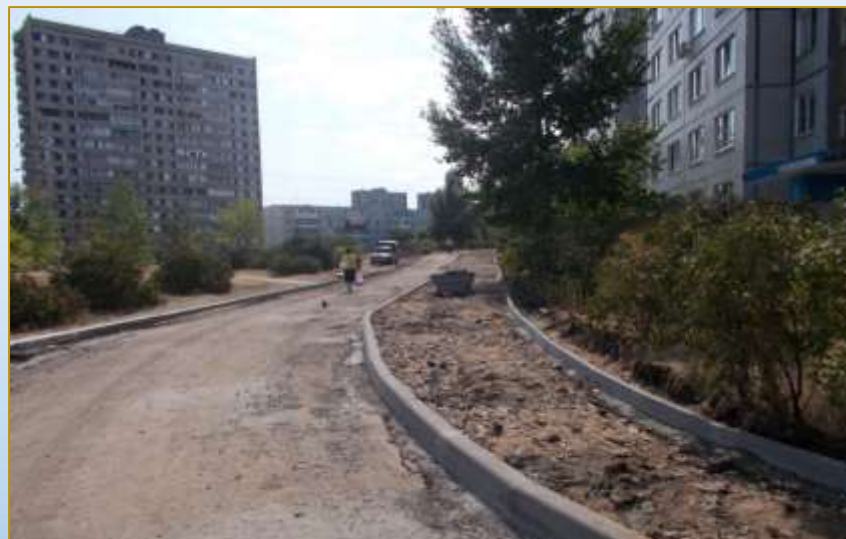
Фото объекта «В работе»
