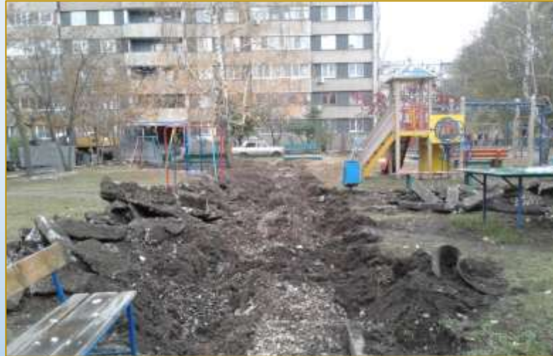
Фото объекта «В работе»
