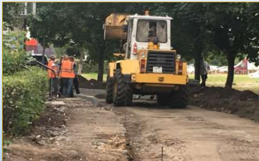
Фото объекта «В работе»
