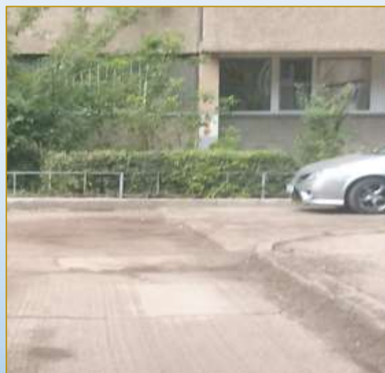
Фото объекта «В работе»
