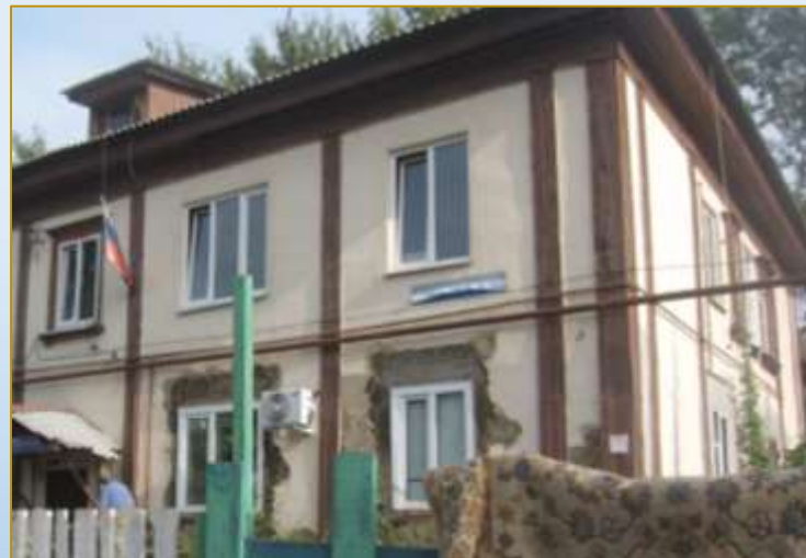
Фото объекта «В работе»
