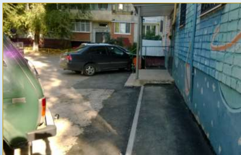
Фото объекта «В работе»
