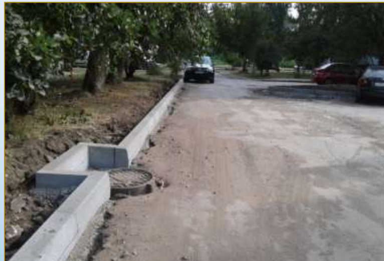
Фото объекта «В работе»
