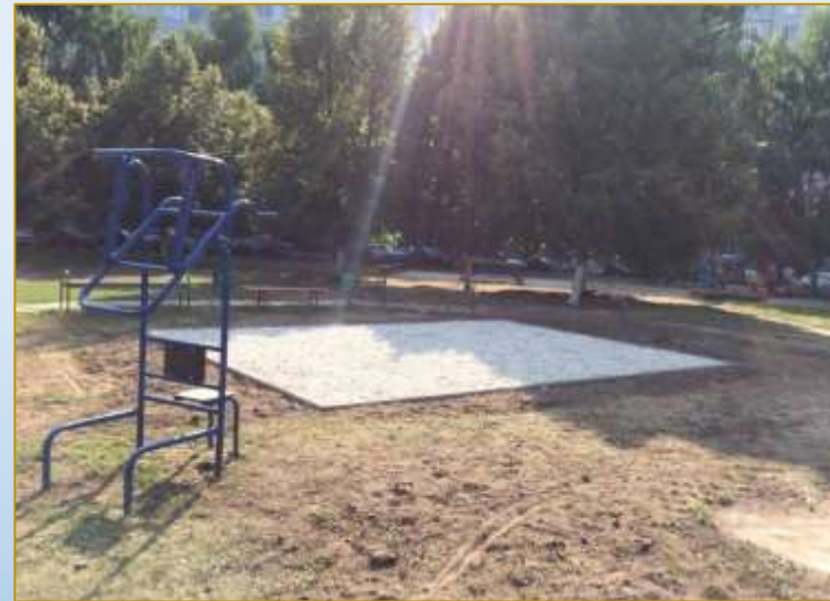
Фото объекта «В работе»
