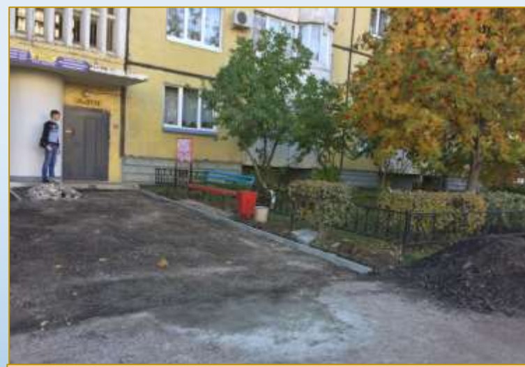
Фото объекта «В работе»
