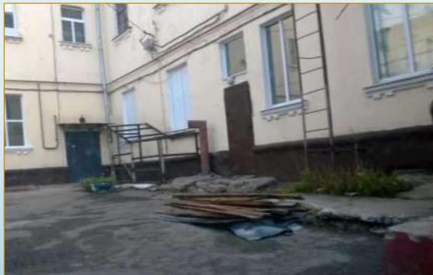
Фото объекта «В работе»
