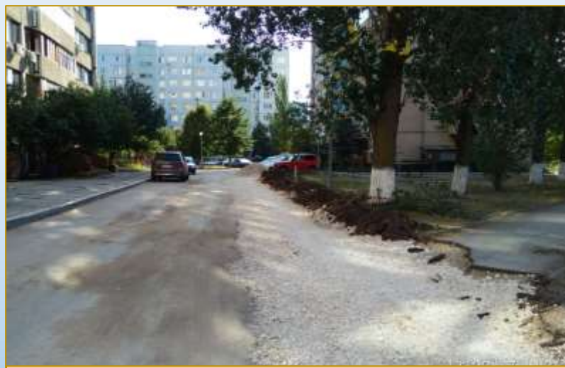
Фото объекта «В работе»
