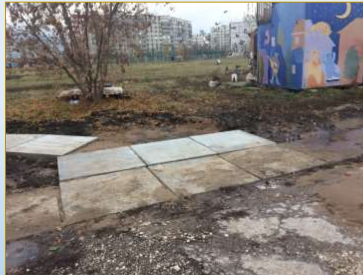
Фото объекта «В работе»
