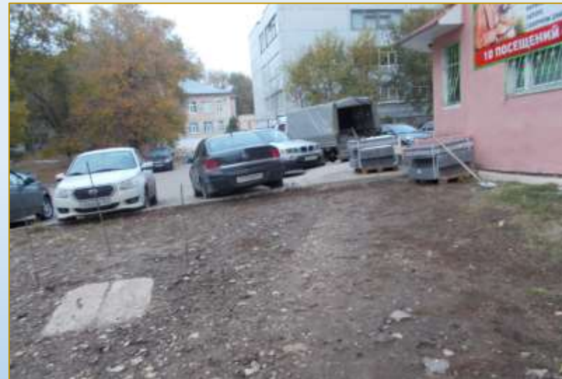
Фото объекта «В работе»
