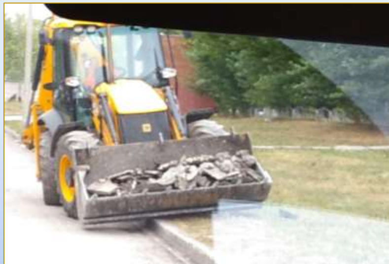
Фото объекта «В работе»
