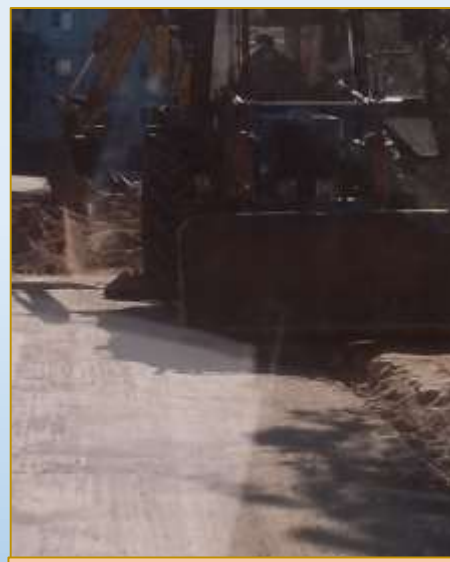
Фото объекта «В работе»
