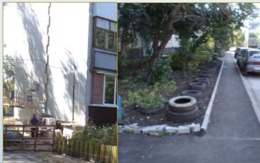
Фото объекта «В работе»
