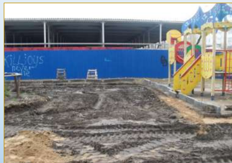
Фото объекта «В работе»
