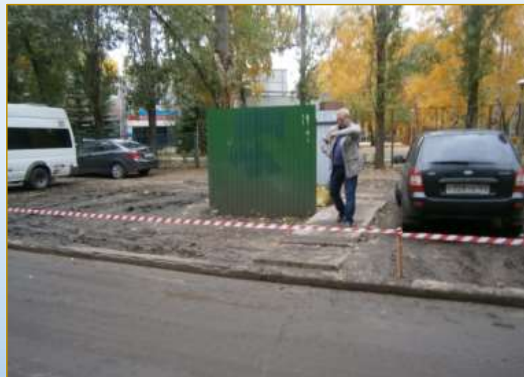
Фото объекта «В работе»
