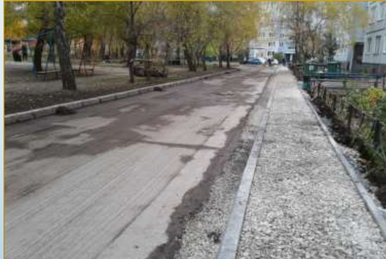
Фото объекта «В работе»
