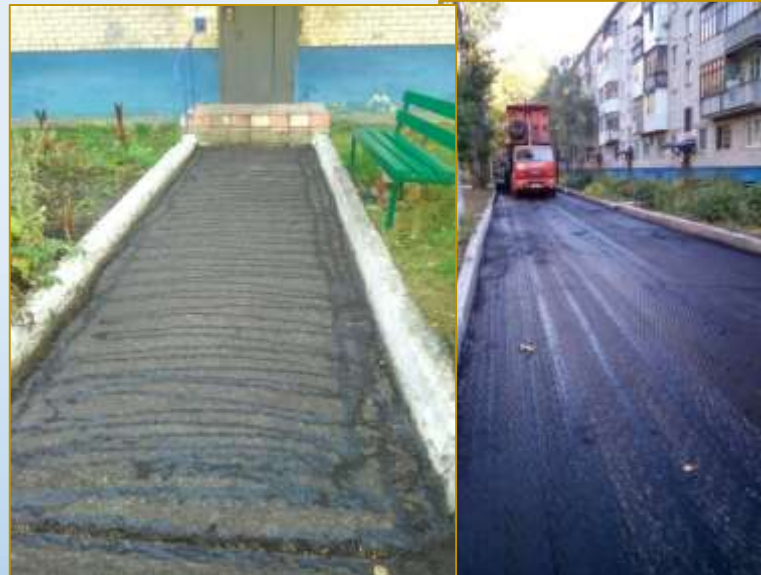
Фото объекта «В работе»
