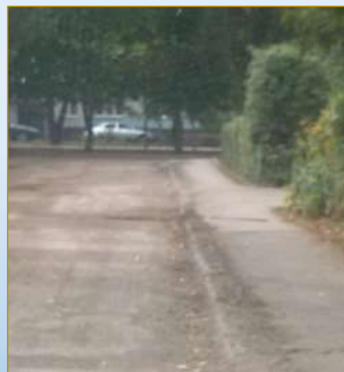
Фото объекта «В работе»
