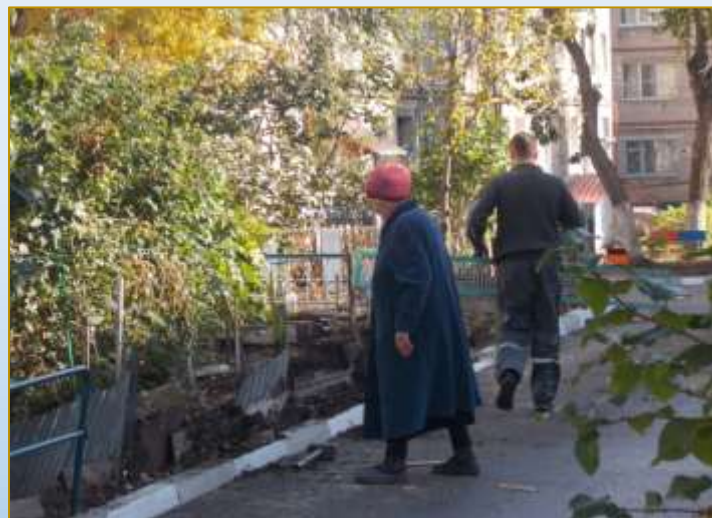
Фото объекта «В работе»
