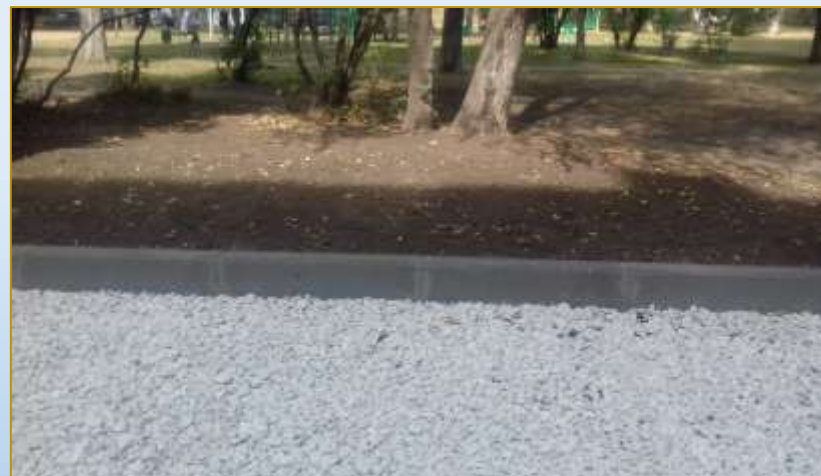
Фото объекта «В работе»
