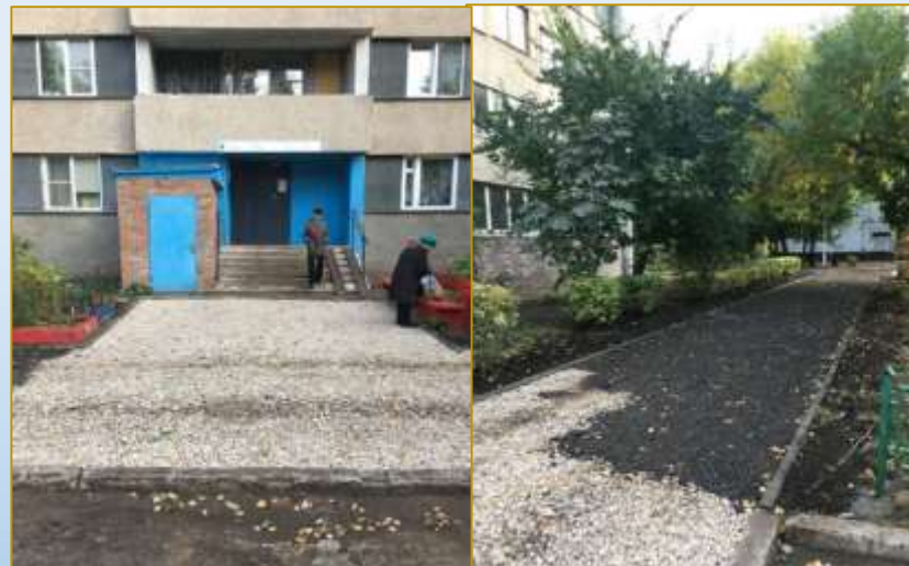
Фото объекта «В работе»
