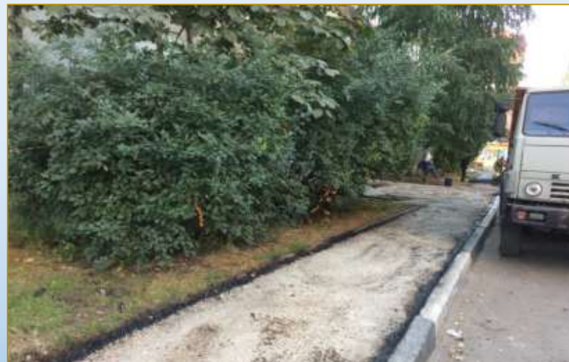
Фото объекта «В работе»
