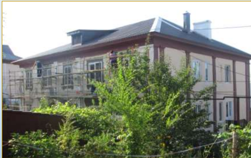
Фото объекта «В работе»
