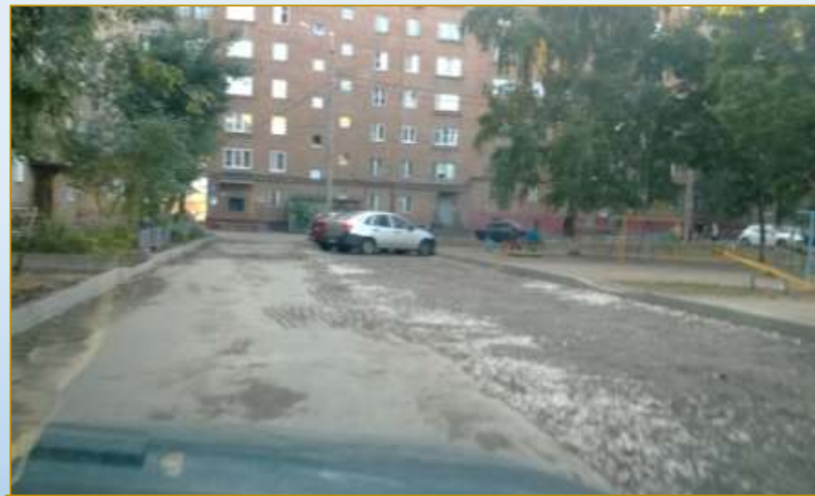
Фото объекта «В работе»
