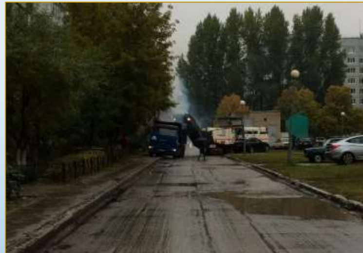
Фото объекта «В работе»
