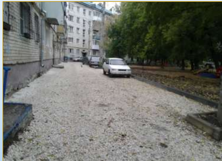
Фото объекта «В работе»
