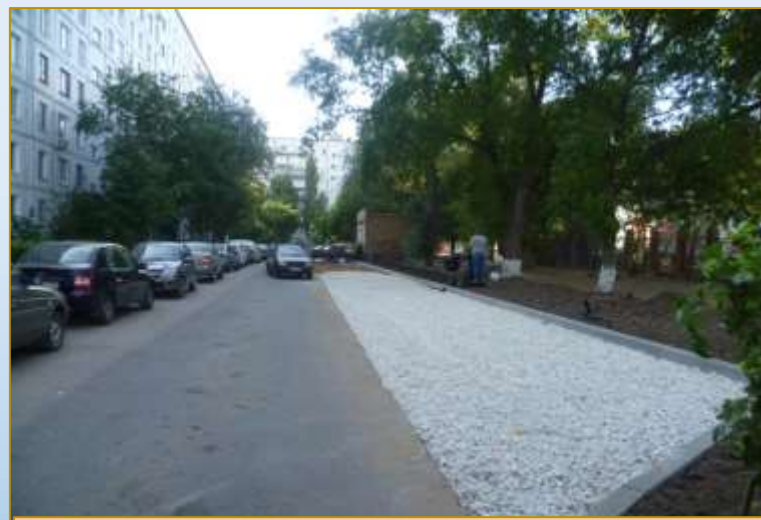
Фото объекта «В работе»
