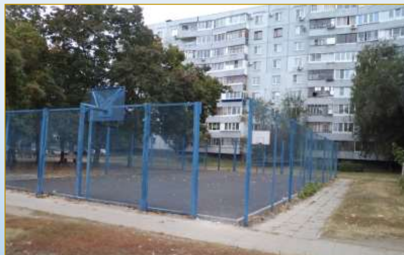
Фото объекта «В работе»
