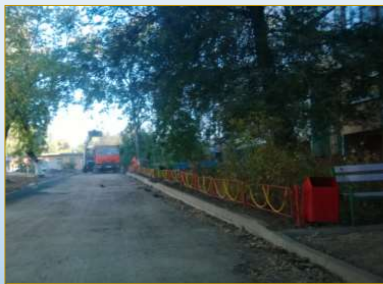
Фото объекта «В работе»
