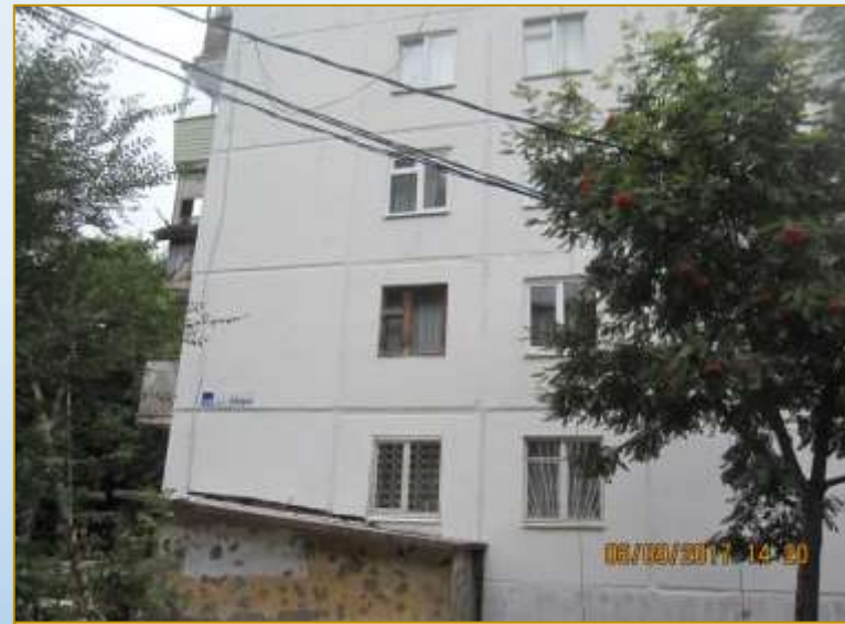
Фото объекта «В работе»
