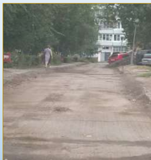
Фото объекта «В работе»
