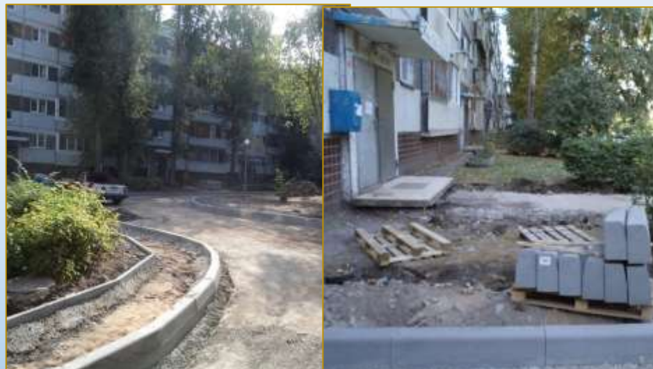
Фото объекта «В работе»
