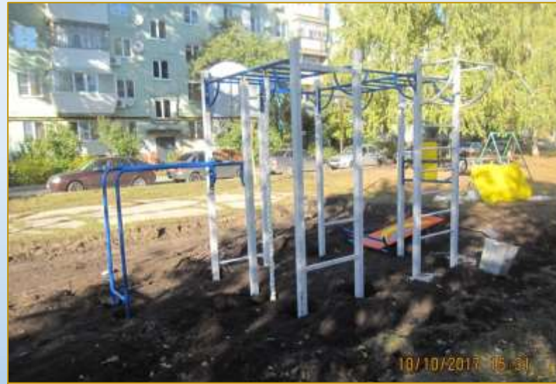
Фото объекта «В работе»
