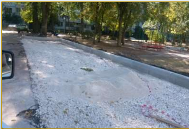
Фото объекта «В работе»
