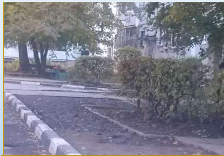
Фото объекта «В работе»
