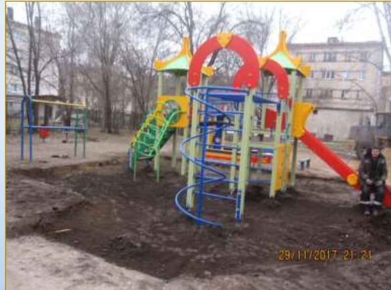
Фото объекта «В работе»
