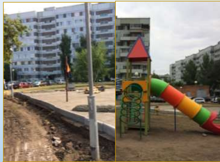
Фото объекта «В работе»
