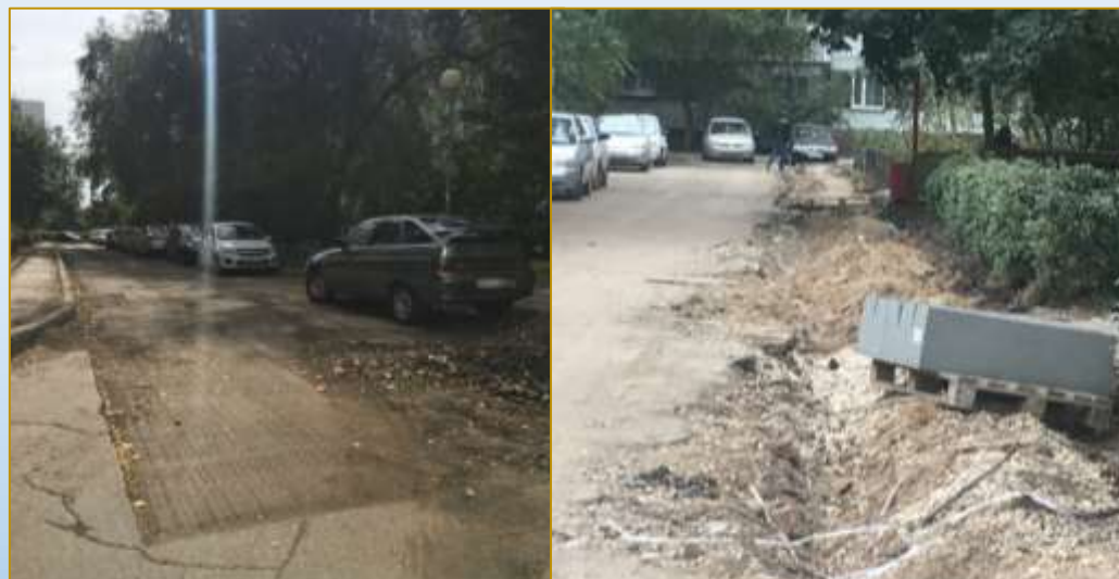
Фото объекта «В работе»
