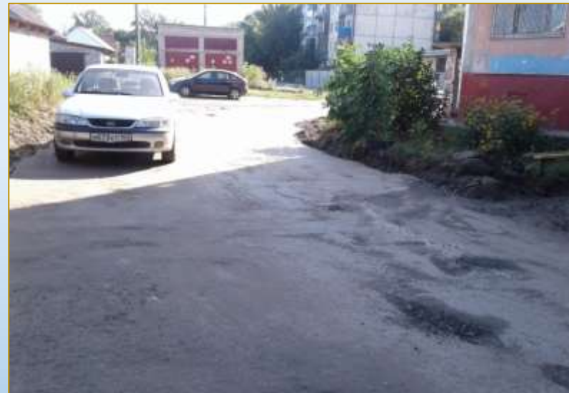
Фото объекта «В работе»
