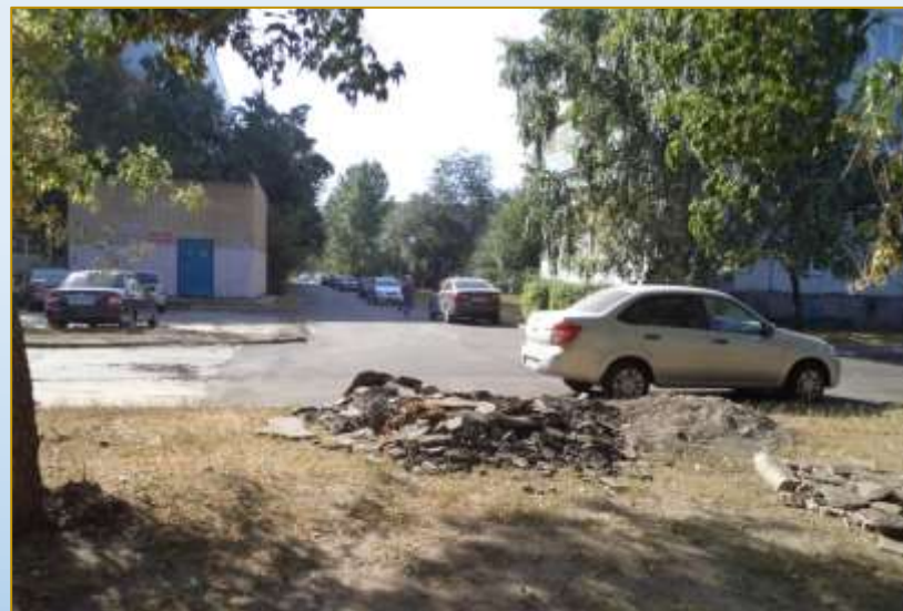
Фото объекта «В работе»
