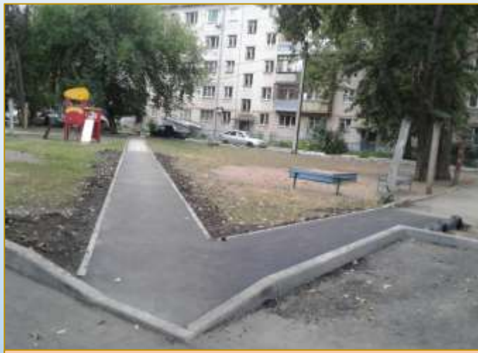
Фото объекта «В работе»
