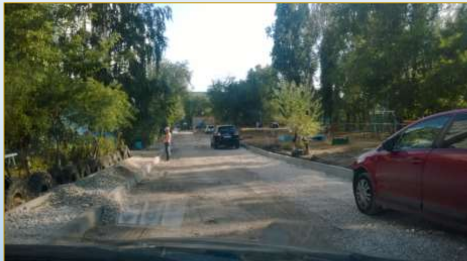
Фото объекта «В работе»
