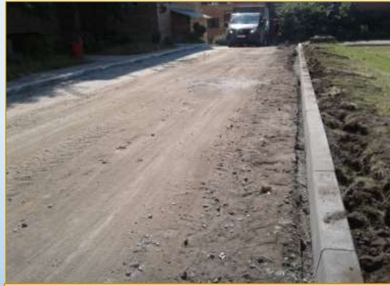
Фото объекта «В работе»
