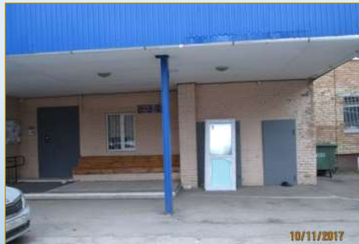
Фото объекта «В работе»
