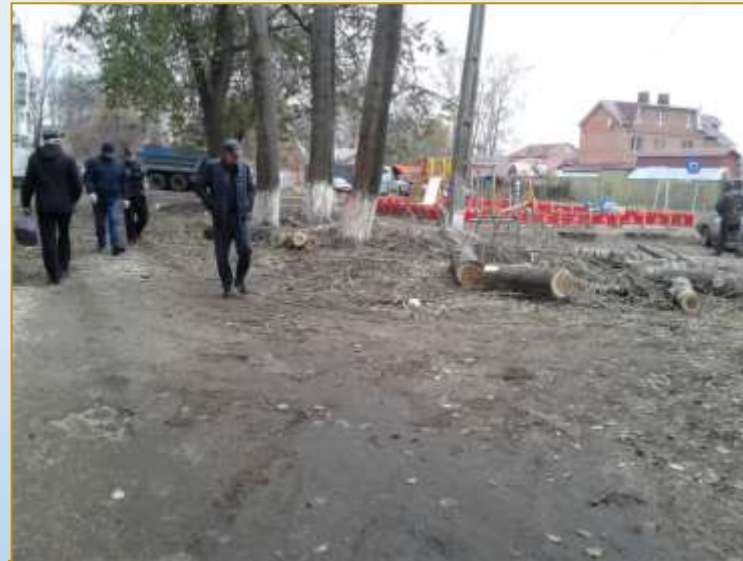
Фото объекта «В работе»
