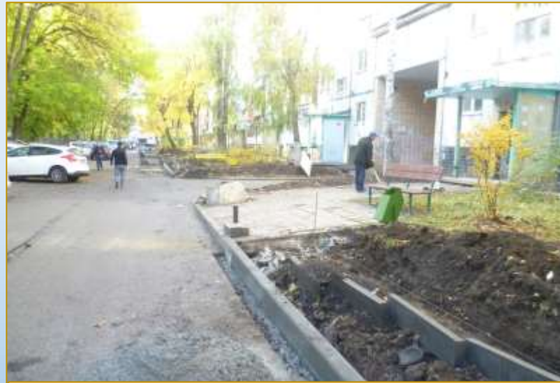
Фото объекта «В работе»
