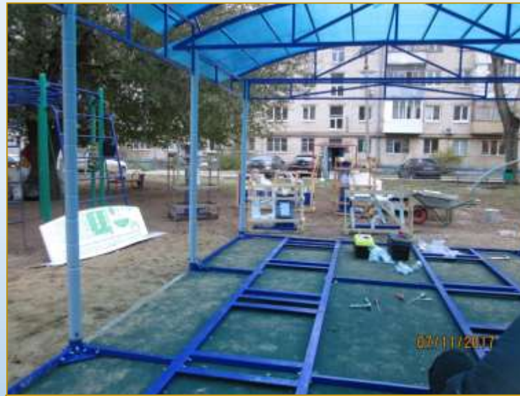
Фото объекта «В работе»
