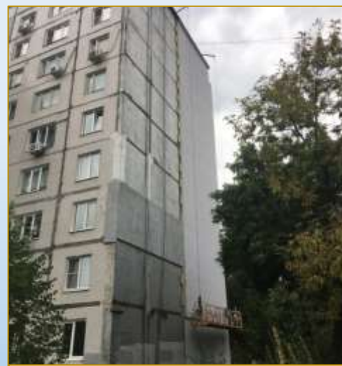
Фото объекта «В работе»
