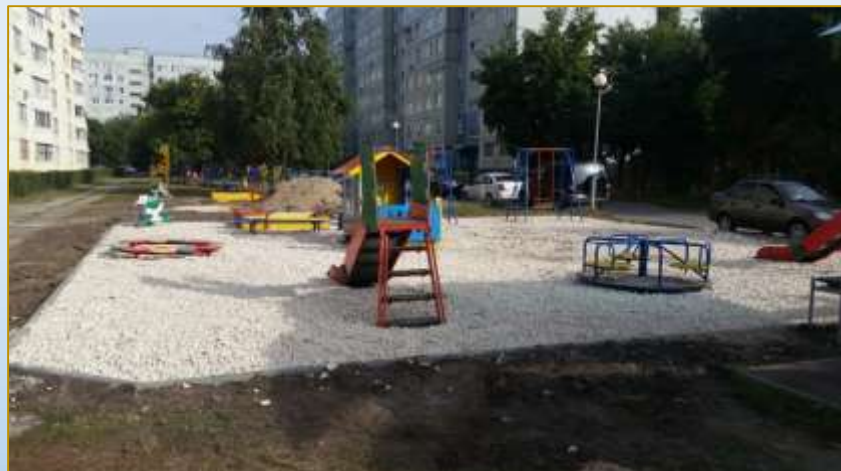
Фото объекта «В работе»
