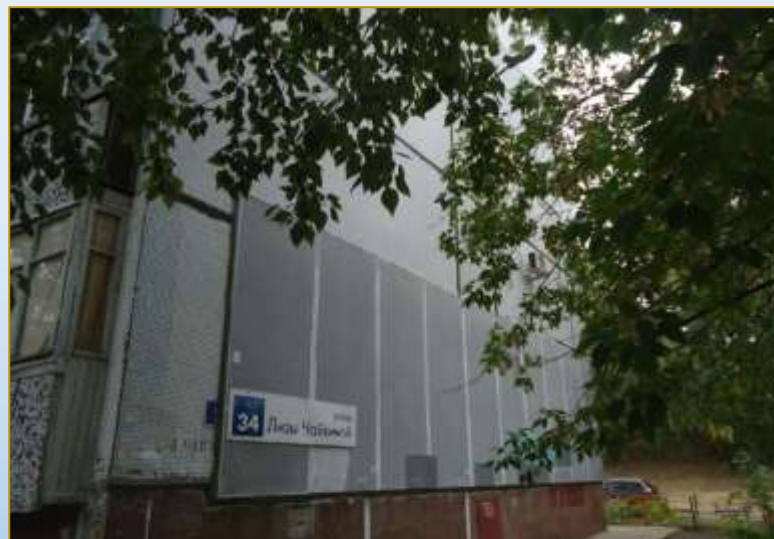
Фото объекта «В работе»
