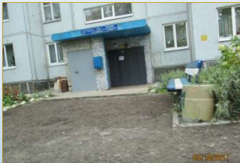
Фото объекта «В работе»
