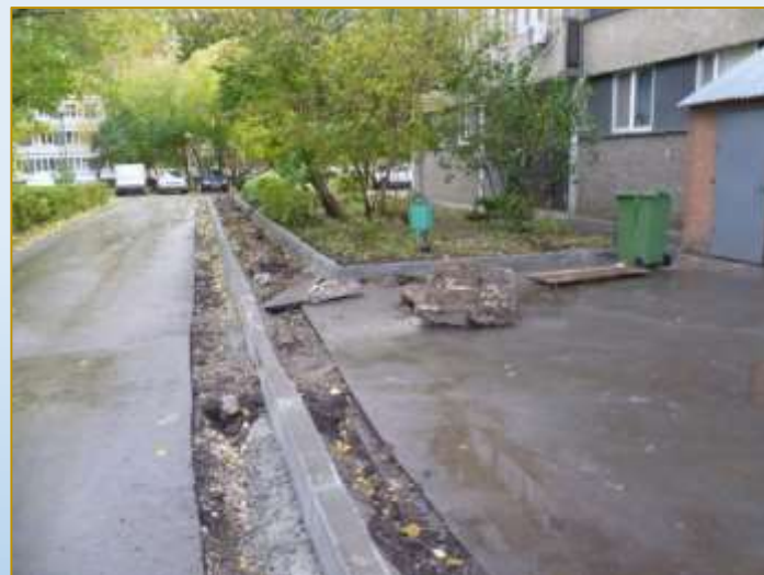
Фото объекта «В работе»
