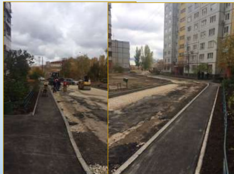
Фото объекта «В работе»
