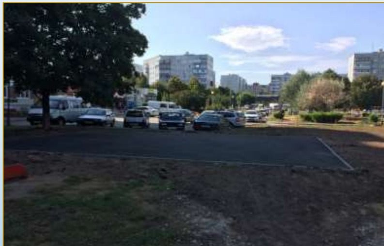
Фото объекта «В работе»
