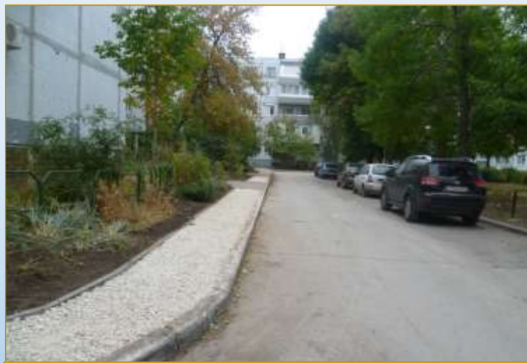
Фото объекта «В работе»
