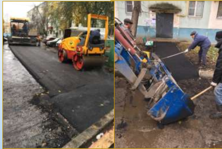
Фото объекта «В работе»
