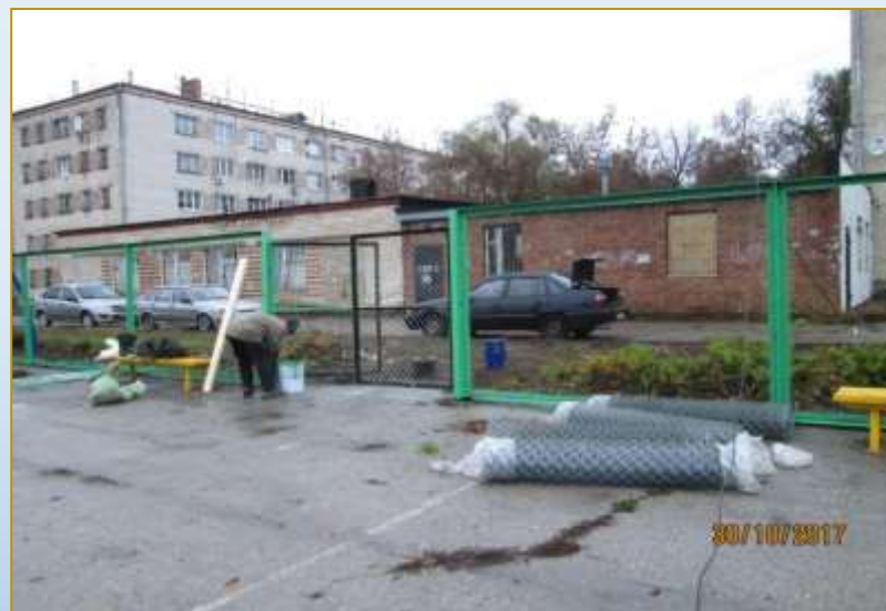
Фото объекта «В работе»
