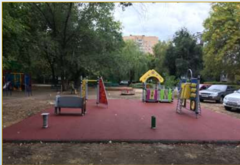
Фото объекта «В работе»
