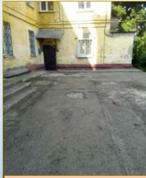
Фото объекта «В работе»
