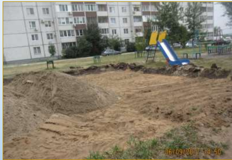
Фото объекта «В работе»
