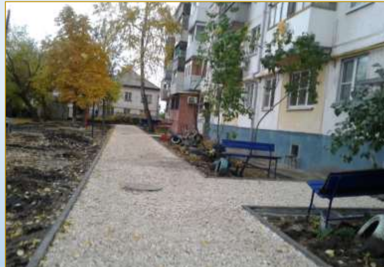
Фото объекта «В работе»
