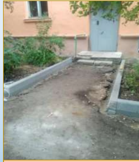
Фото объекта «В работе»
