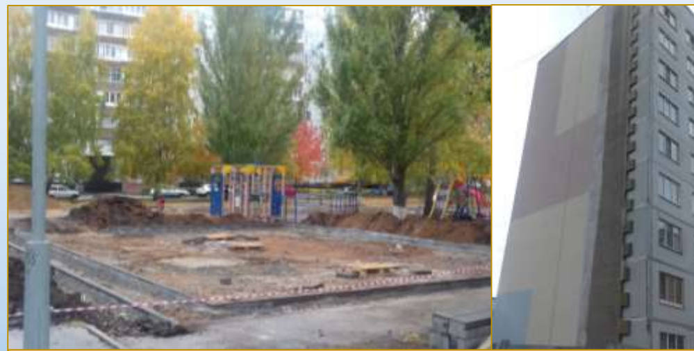
Фото объекта «В работе»
