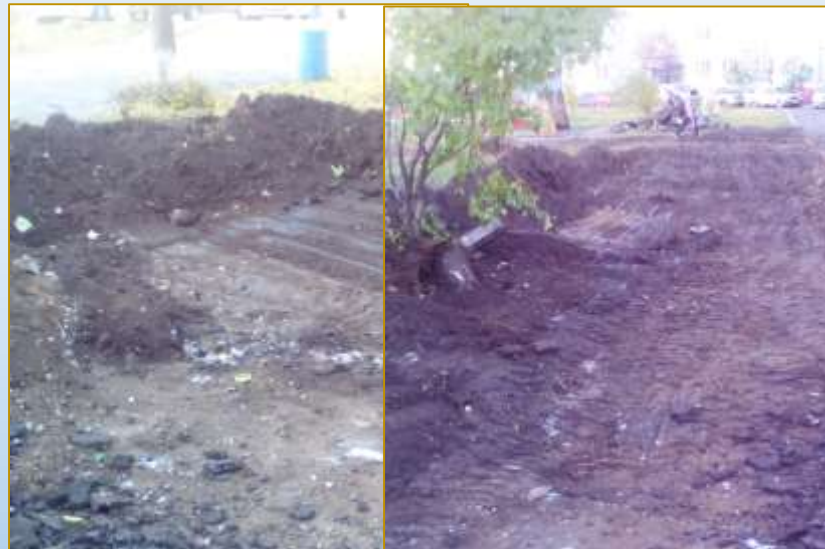
Фото объекта «В работе»
