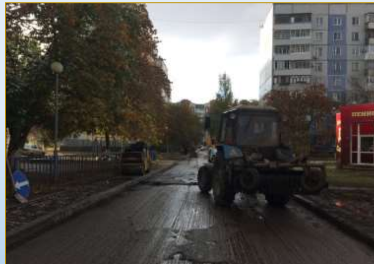
Фото объекта «В работе»
