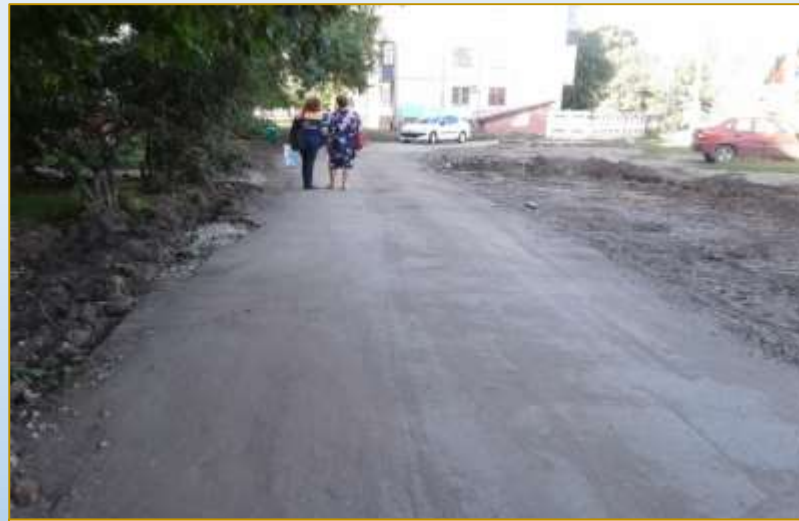
Фото объекта «В работе»
