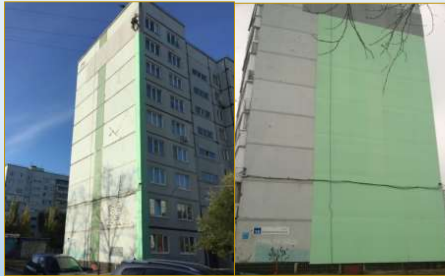
Фото объекта «В работе»
