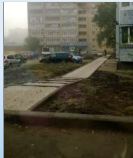
Фото объекта «В работе»
