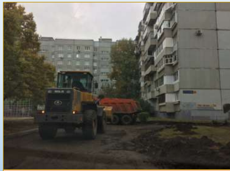
Фото объекта «В работе»
