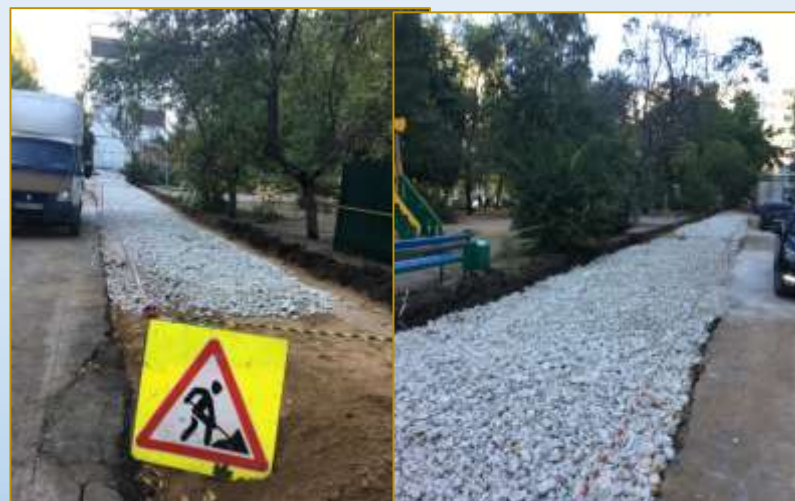
Фото объекта «В работе»
