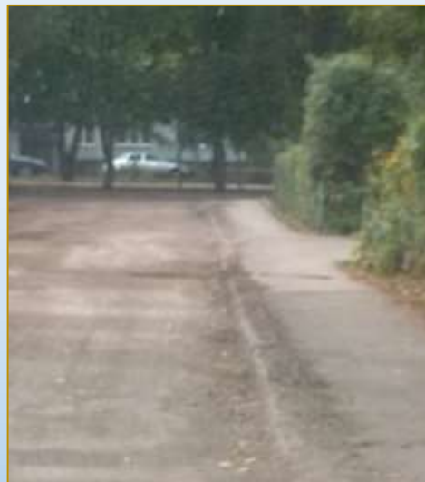
Фото объекта «В работе»
