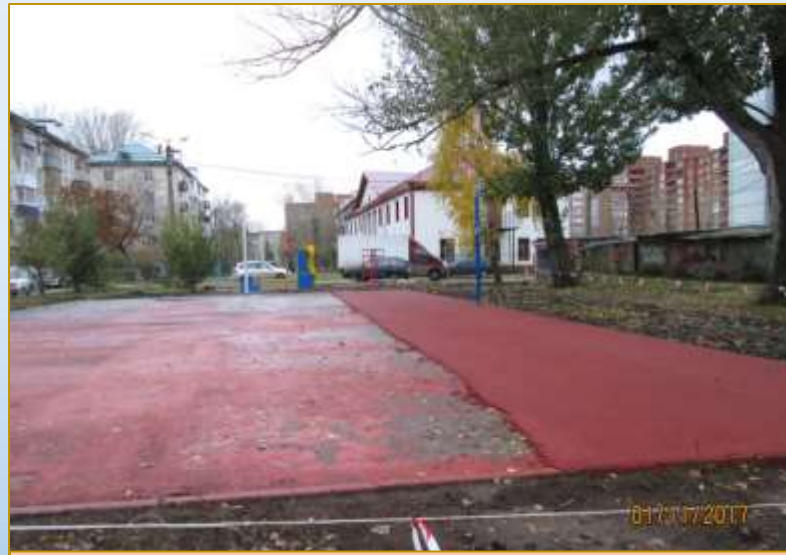
Фото объекта «В работе»
