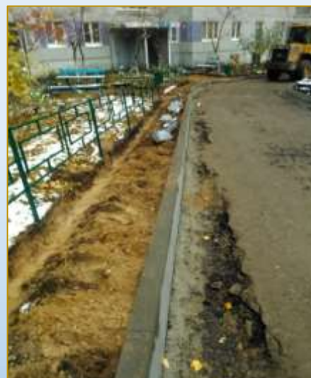
Фото объекта «В работе»
