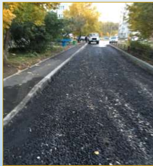
Фото объекта «В работе»
