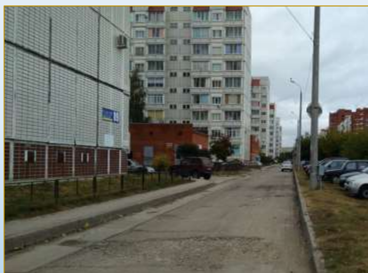
Фото объекта «В работе»
