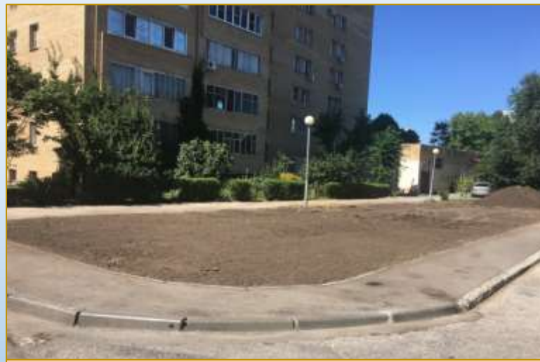
Фото объекта «В работе»
