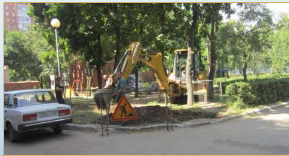
Фото объекта «В работе»
