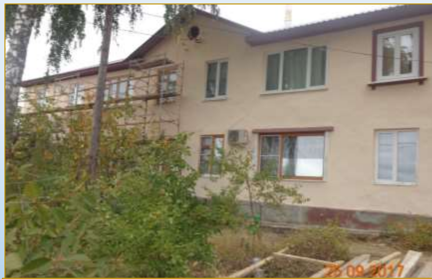
Фото объекта «В работе»
