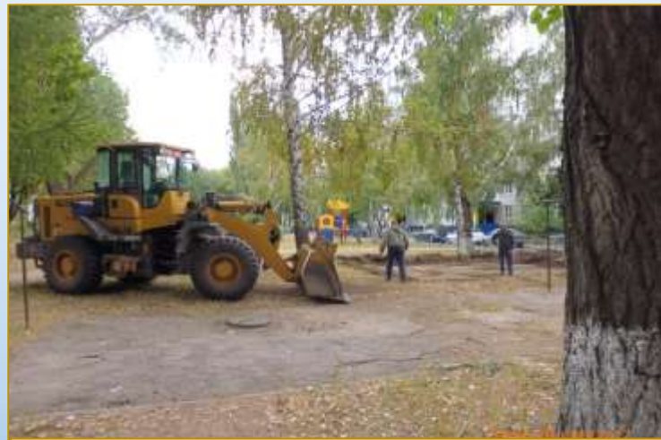
Фото объекта «В работе»
