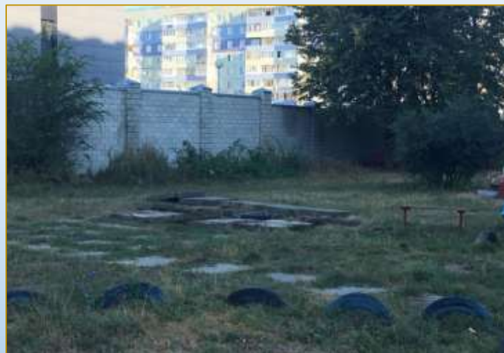
Фото объекта «В работе»
