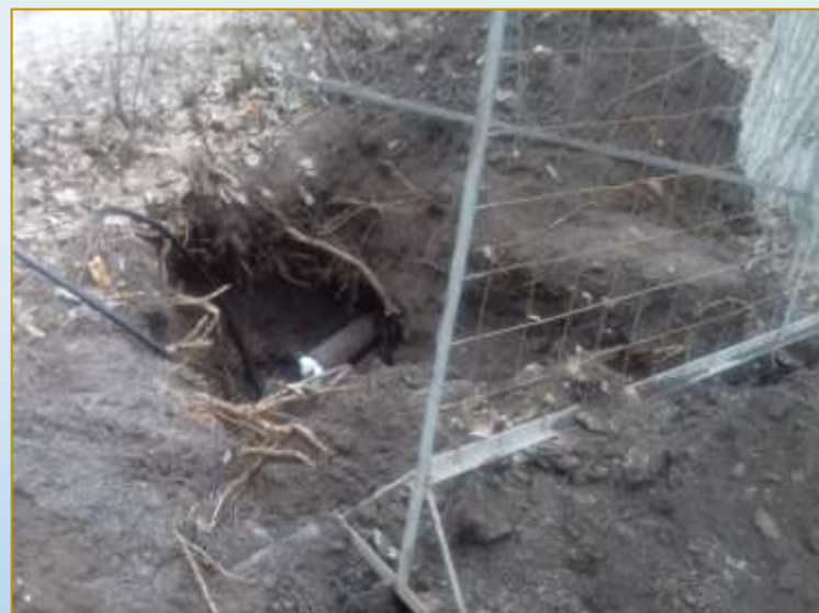
Фото объекта «В работе»
