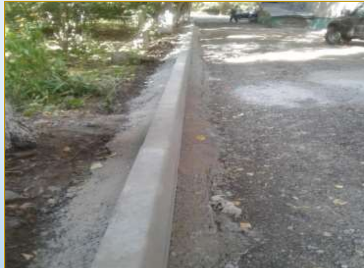
Фото объекта «В работе»
