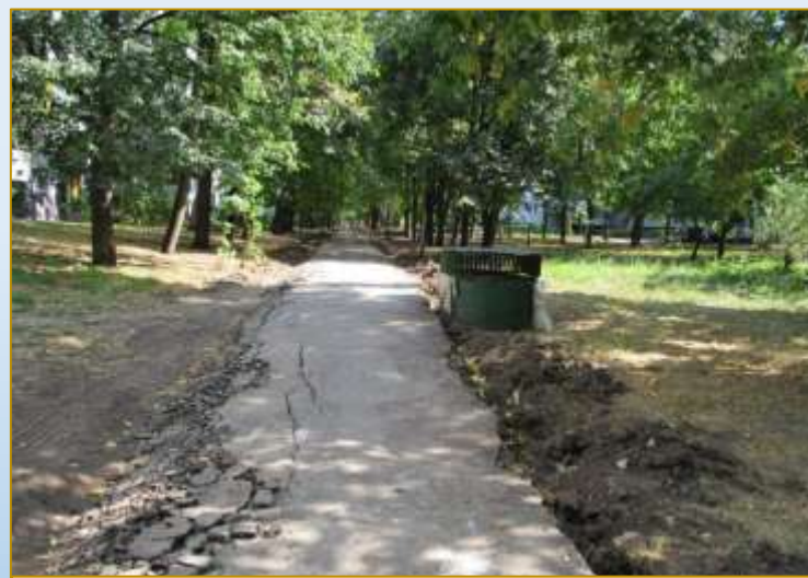
Фото объекта «В работе»
