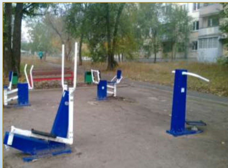
Фото объекта «В работе»
