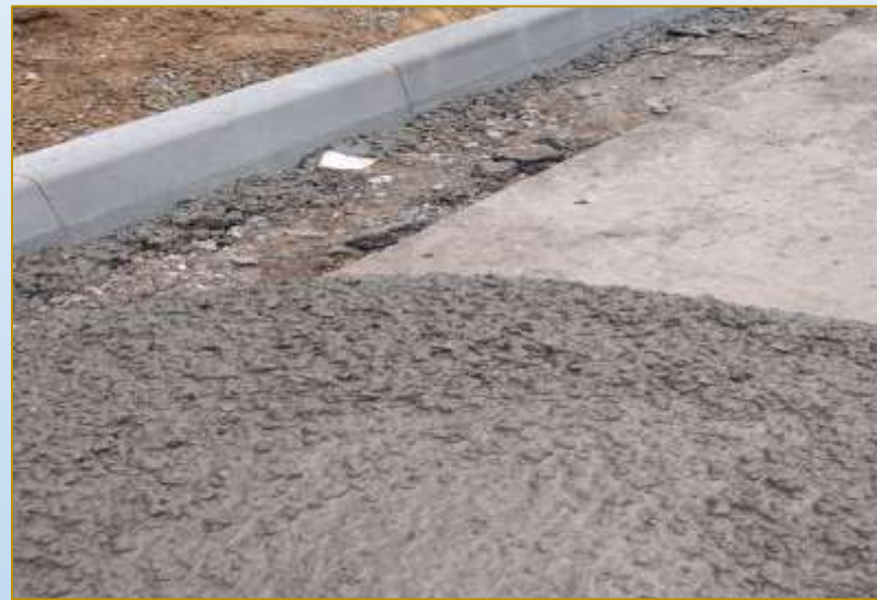
Фото объекта «В работе»
