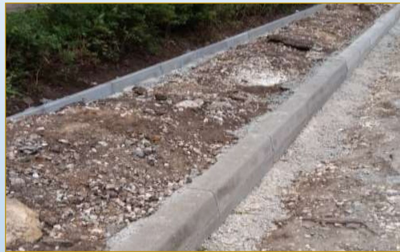
Фото объекта «В работе»
