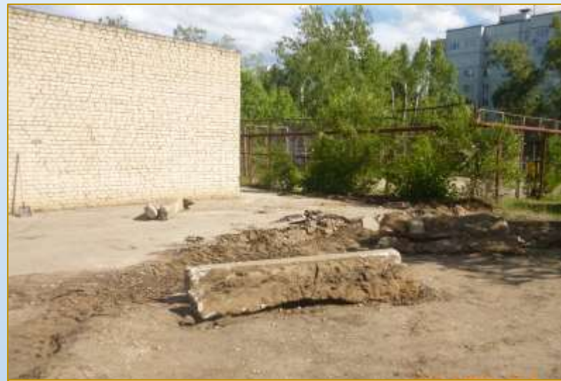
Фото объекта «В работе»
