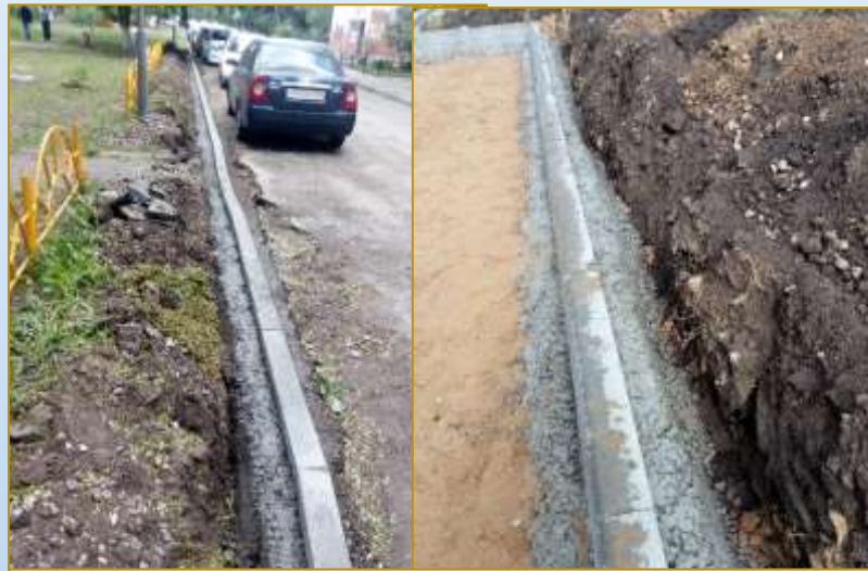
Фото объекта «В работе»
