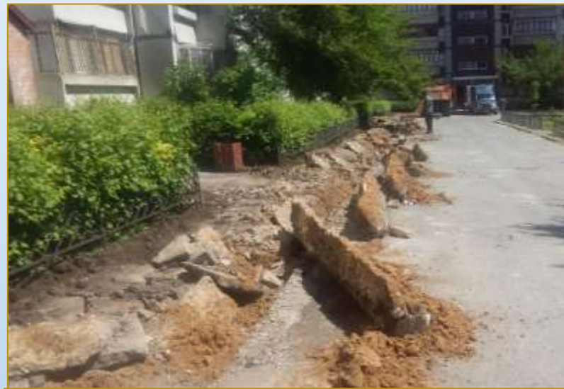
Фото объекта «В работе»
