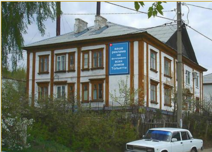
Фото объекта «До»
