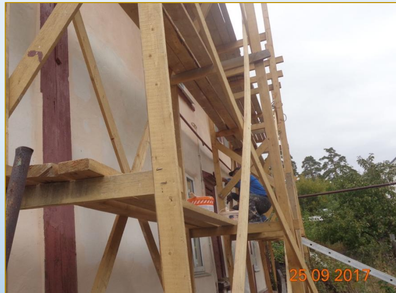
Фото объекта «В работе»
