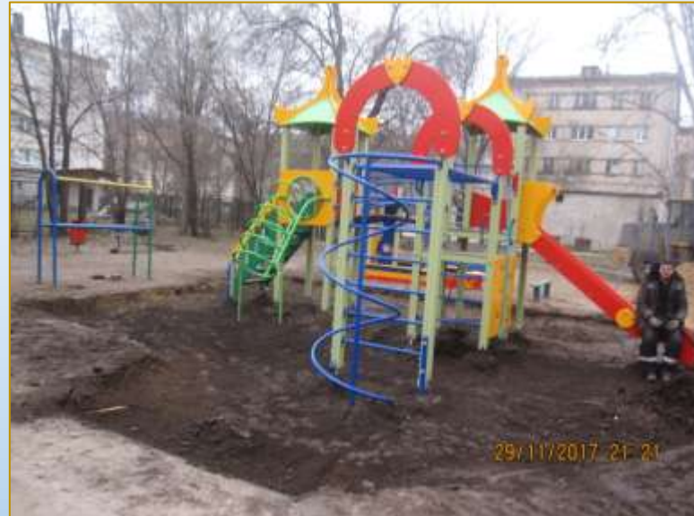
Фото объекта «В работе»
