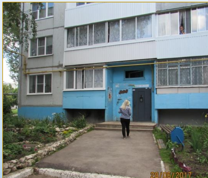
Фото объекта «До»
