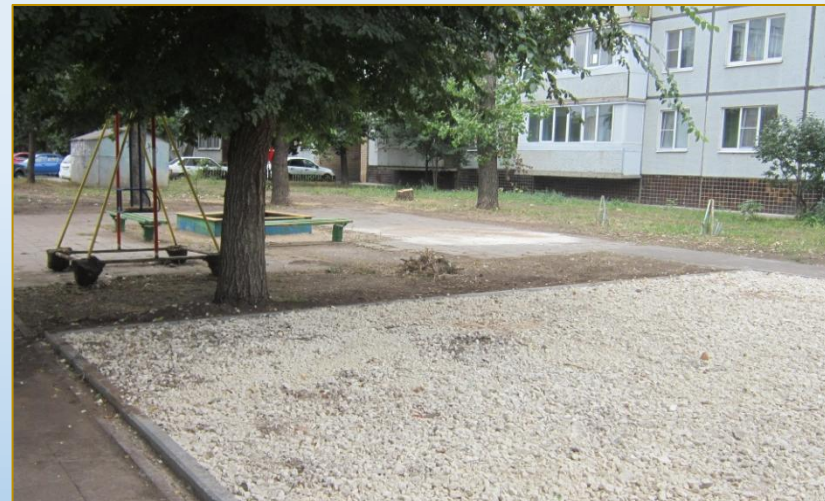
Фото объекта «В работе»
