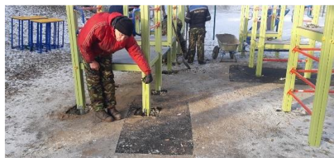
Фото объекта «В работе»
