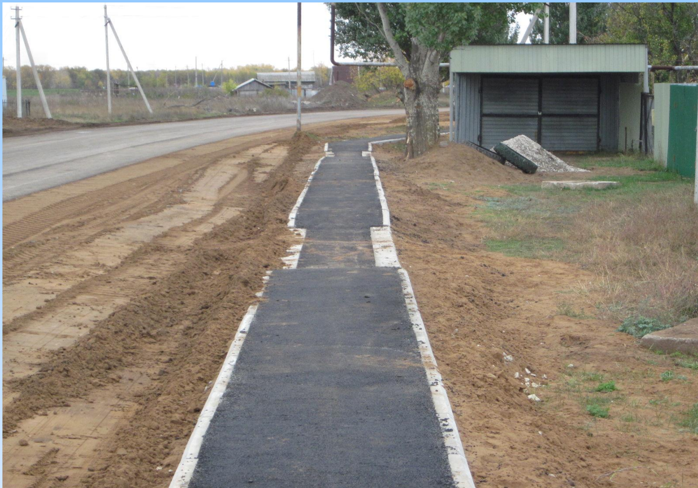
Бортовой камень в пониженных местах установлен «плашмя»
