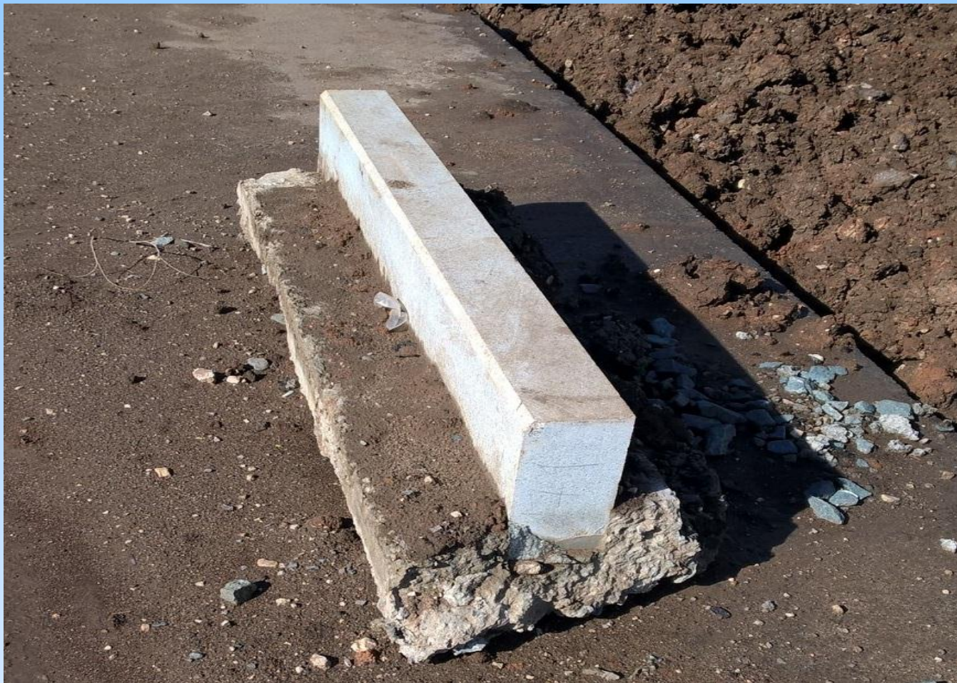
Пример правильно омоноличенного бортового камня
