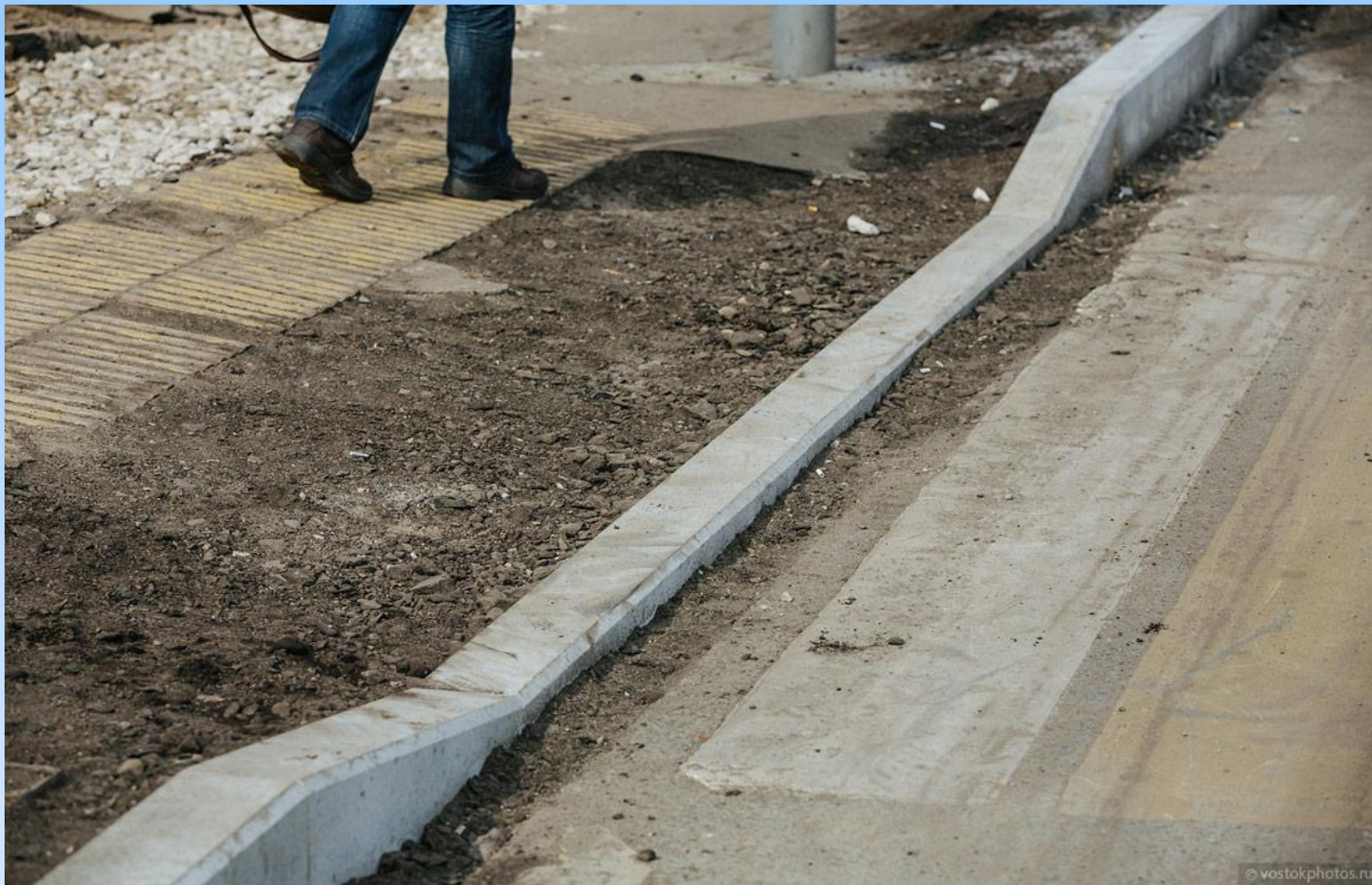
Правильная установка бортового камня в заниженных местах
