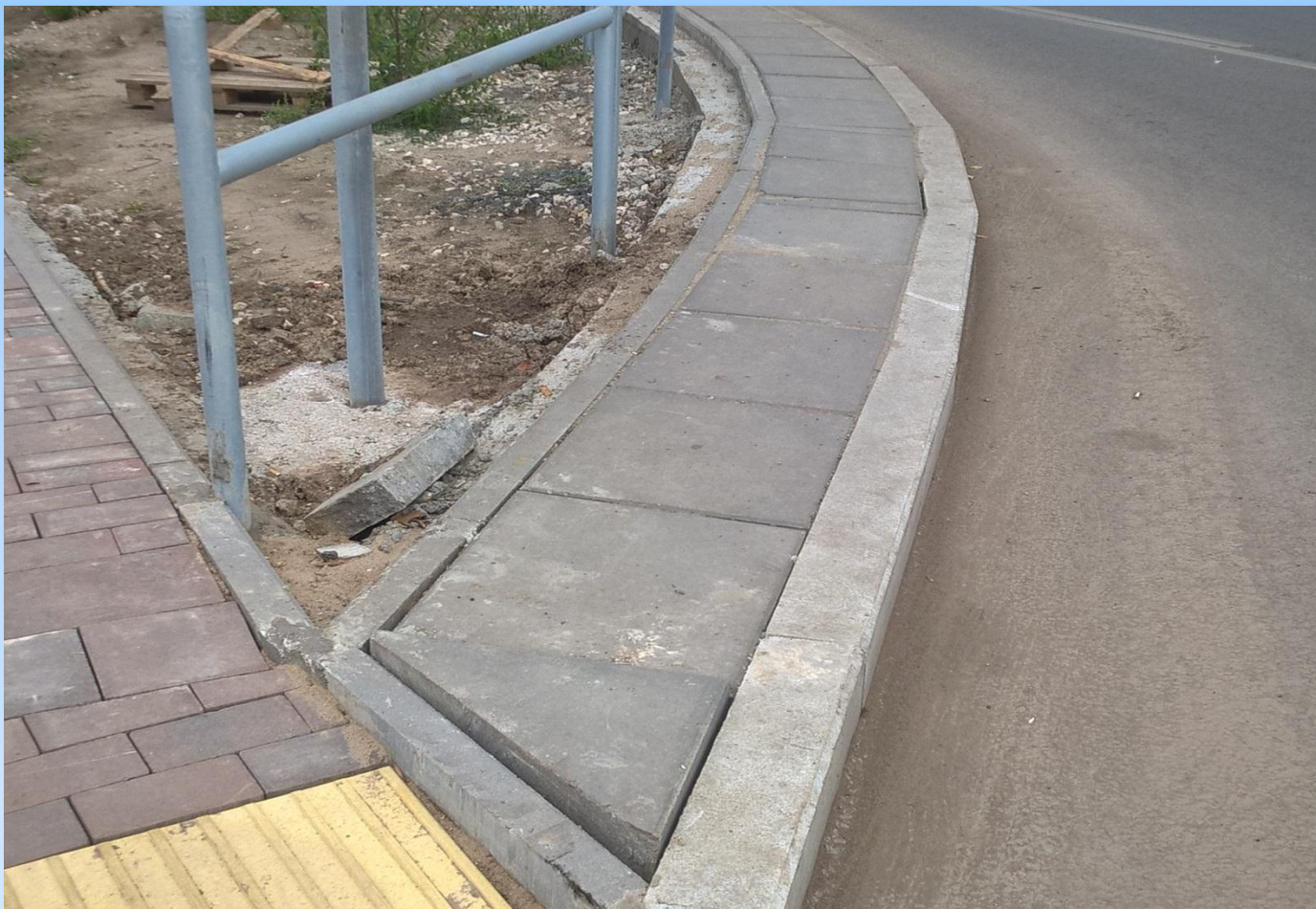
Завышение придорожного элемента относительно бортовых камней на высоту более 2 мм
