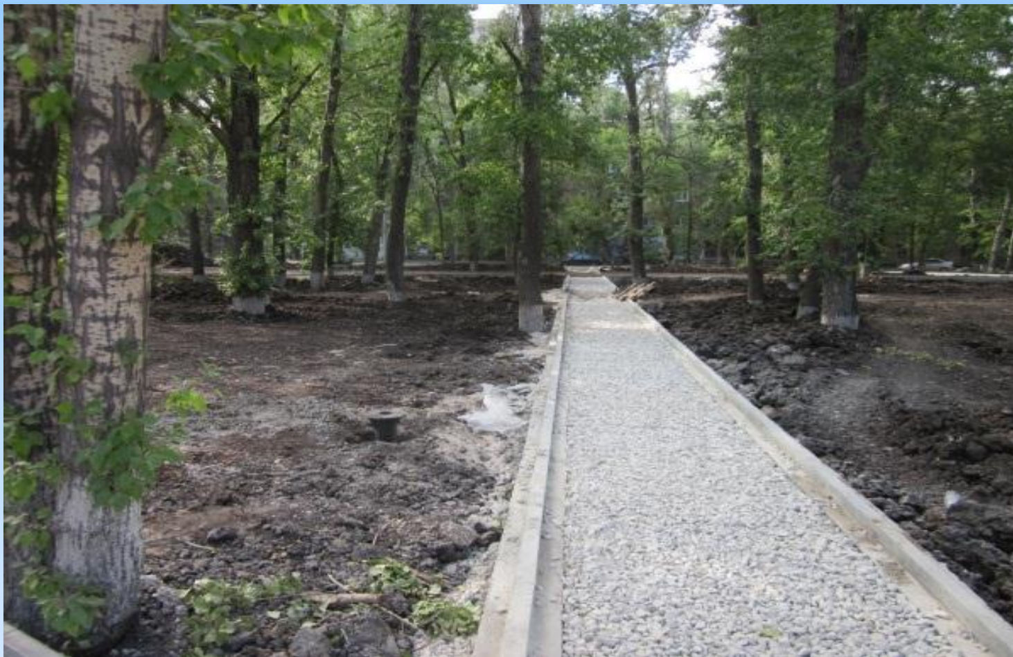
Правильно установленный бортовой камень
