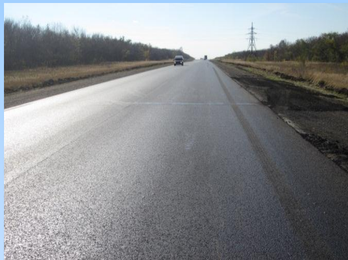
Однородное асфальтобетонное покрытие. Качественно выполненные продольные и поперечные сопряжения асфальтобетонных полос
