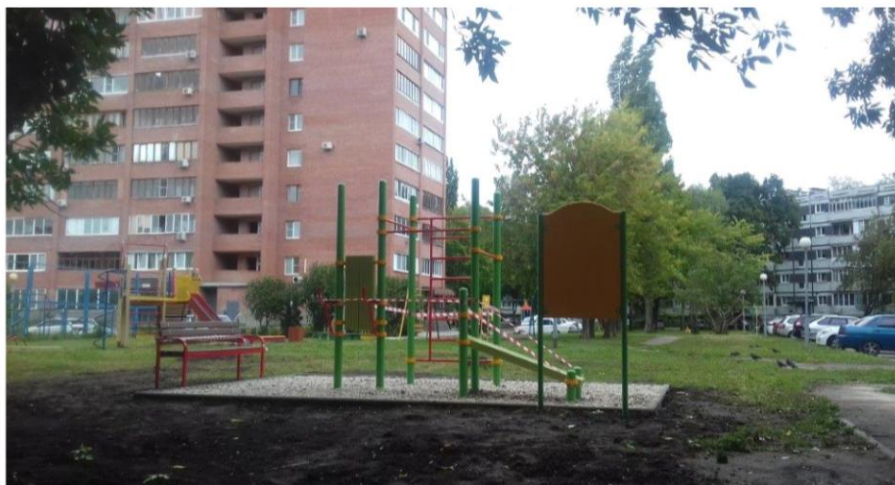
Фото объекта «В работе»
