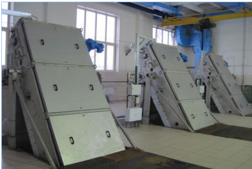
Здание решеток (пример)
