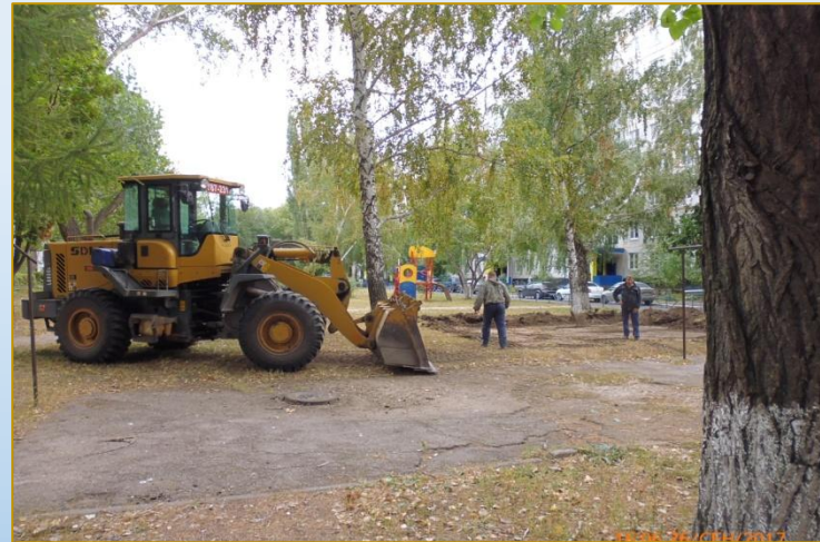
Фото объекта «В работе»
