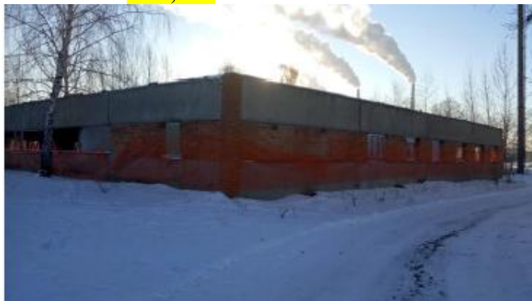
Рисунок 1 – Фотография здания насосной станции 1
