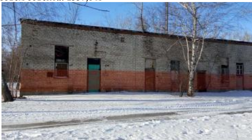
Рисунок 3 – Фотография здания насосной станции 2
