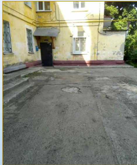
Фото объекта «В работе»
