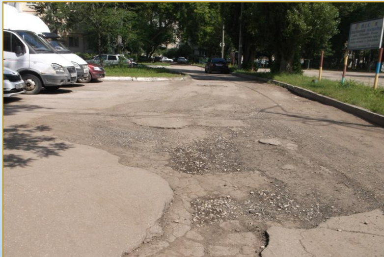
Фото объекта «До»
