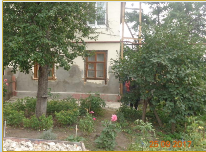
Фото объекта «В работе»
