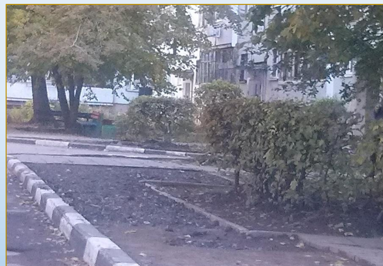
Фото объекта «В работе»
