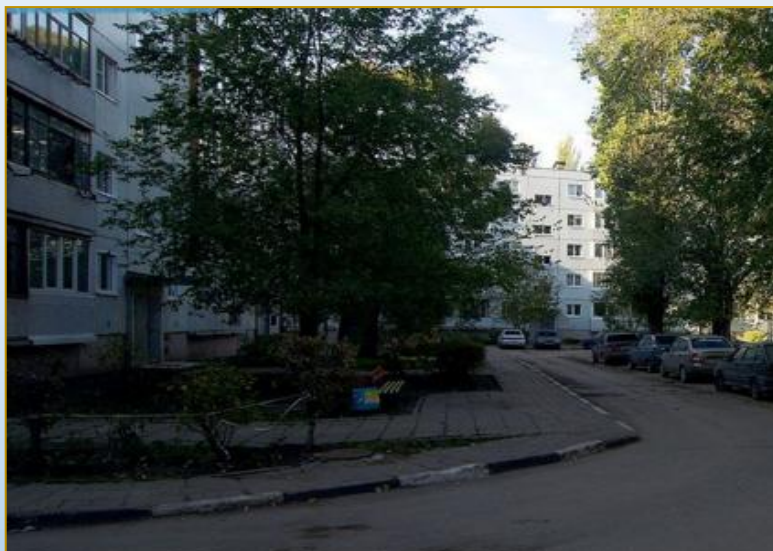
Фото объекта «До»
