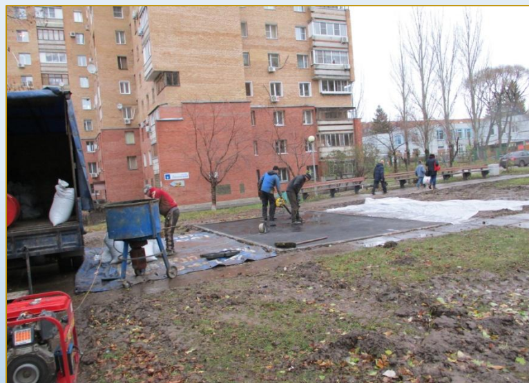
Фото объекта «В работе»
