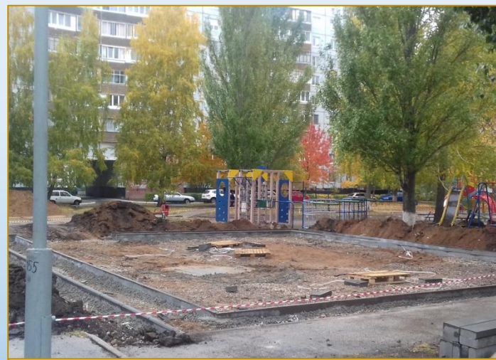
Фото объекта «В работе»
