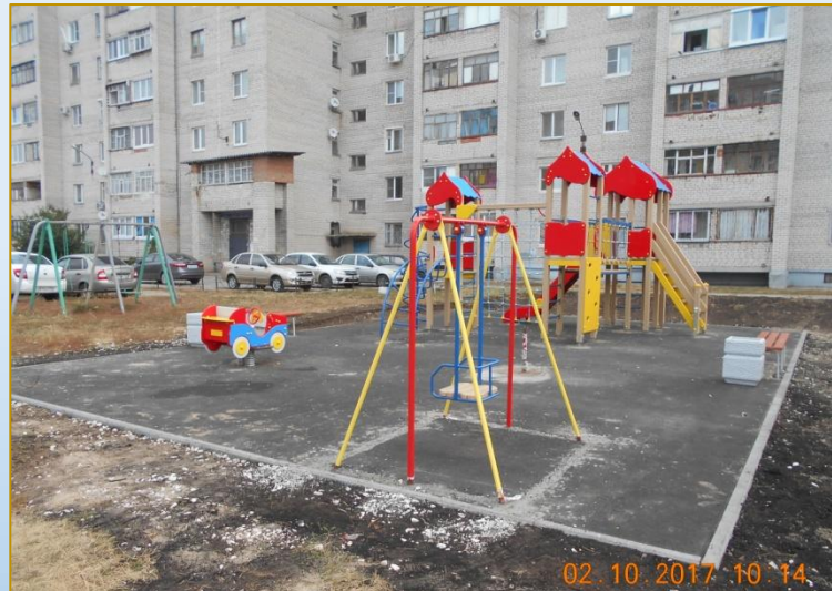
Фото объекта «В работе»
