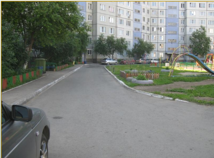
Фото объекта «До»
