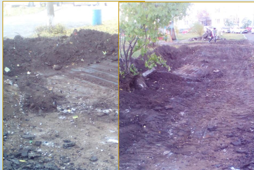
Фото объекта «В работе»
