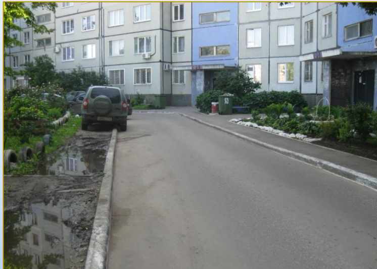
Фото объекта «До»
