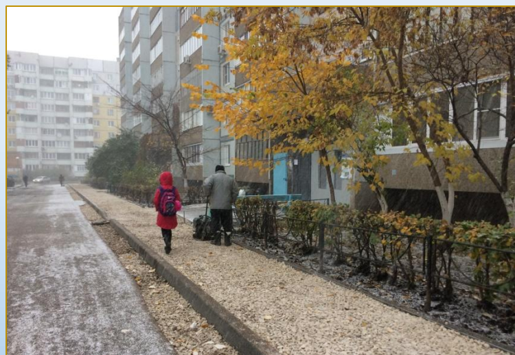
Фото объекта «В работе»
