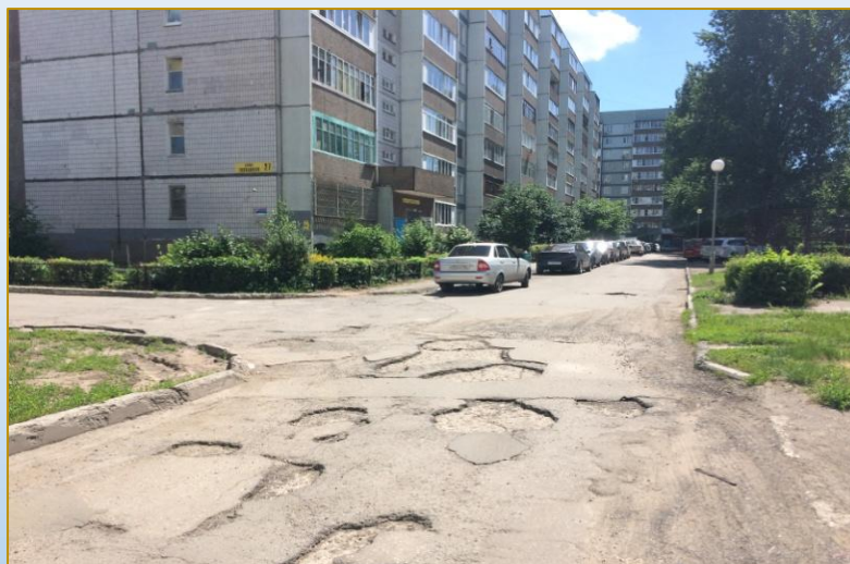
Фото объекта «До»
