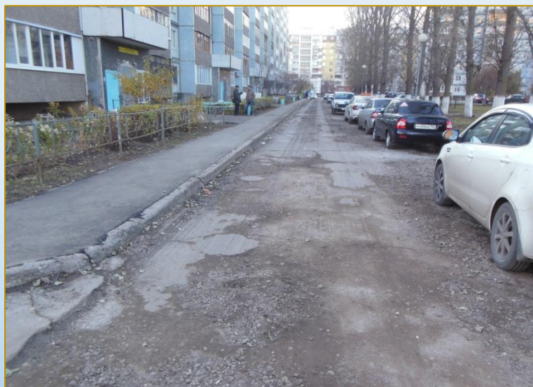
Фото объекта «В работе»
