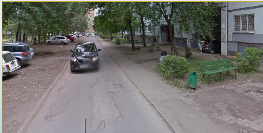
Фото объекта «До»
