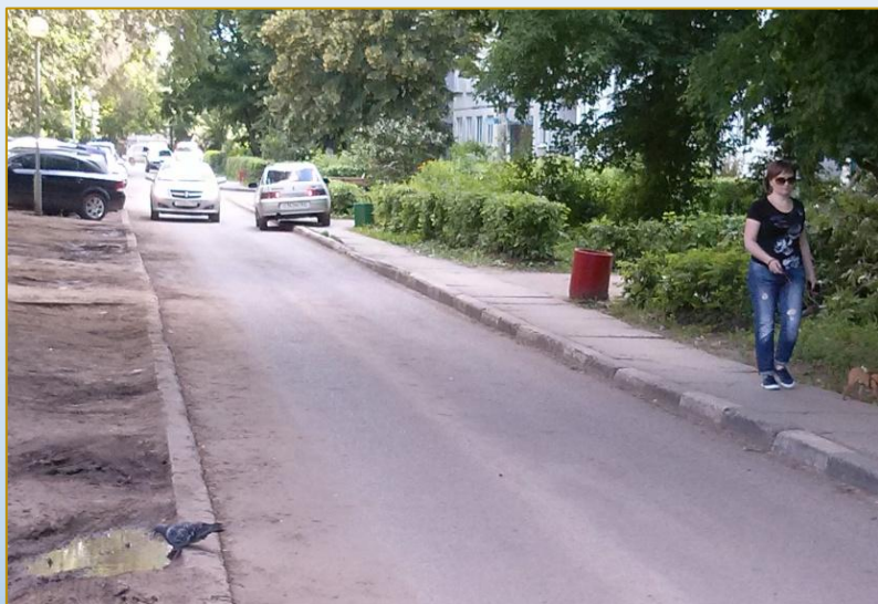
Фото объекта «До»
