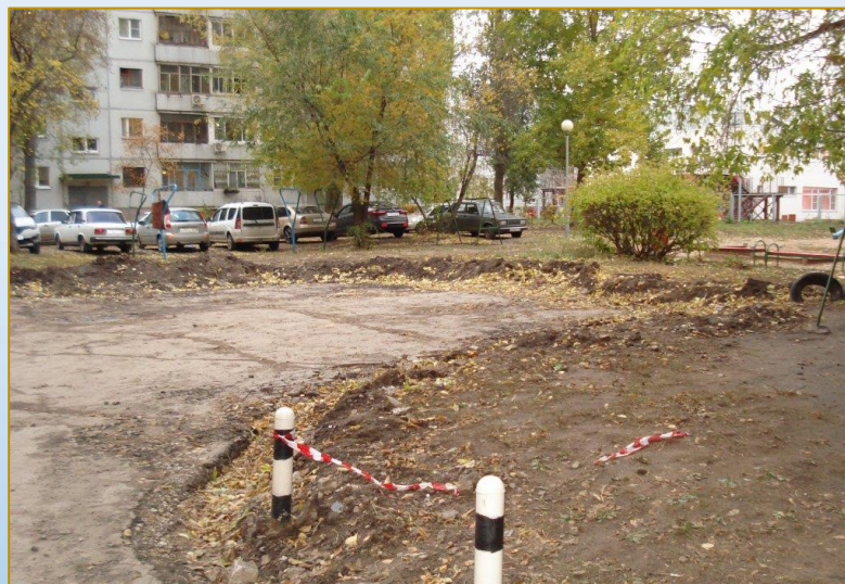
Фото объекта «В работе»
