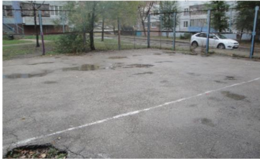
Фото объекта «До»
