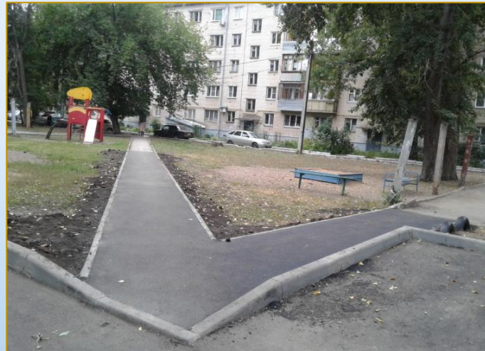
Фото объекта «В работе»
