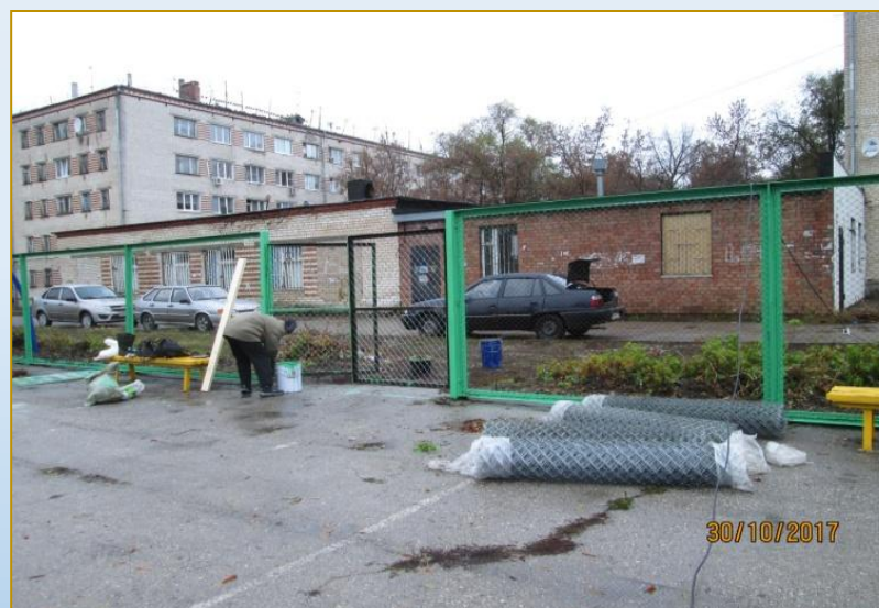
Фото объекта «В работе»
