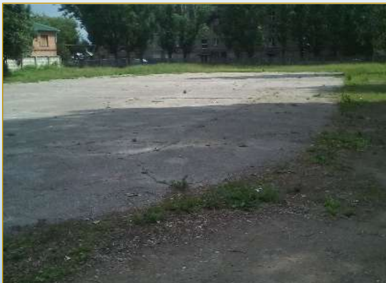
Фото объекта «До»
