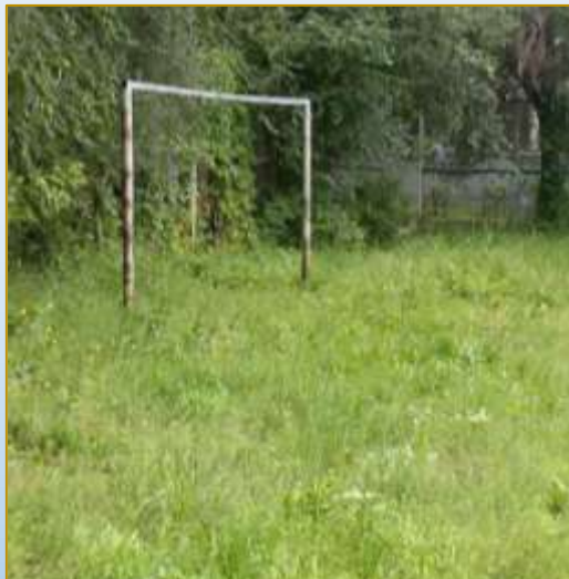
Фото объекта «До»
