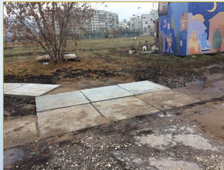
Фото объекта «В работе»
