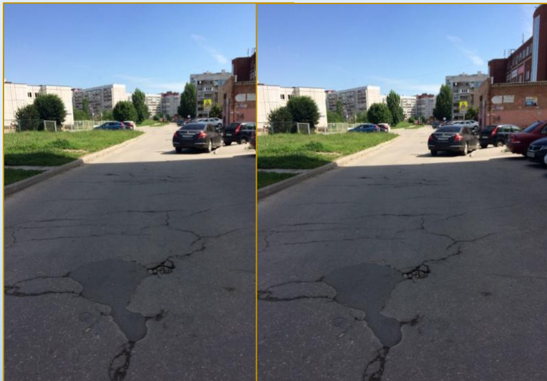
Фото объекта «До»
