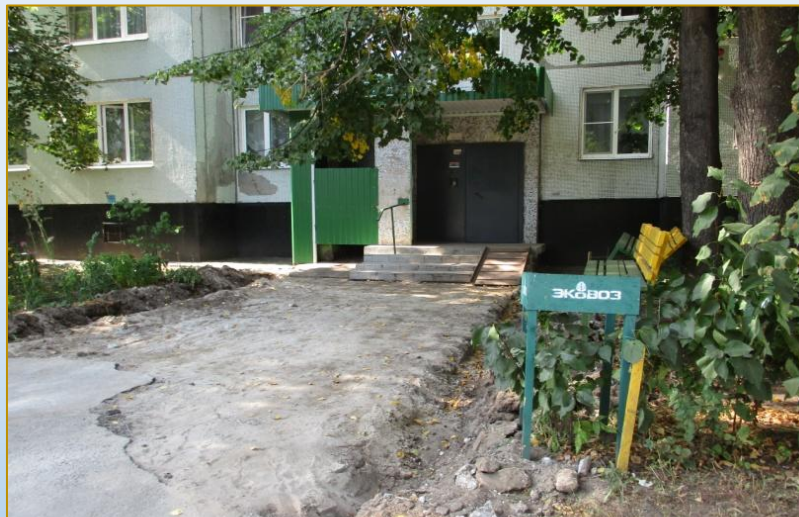
Фото объекта «В работе»
