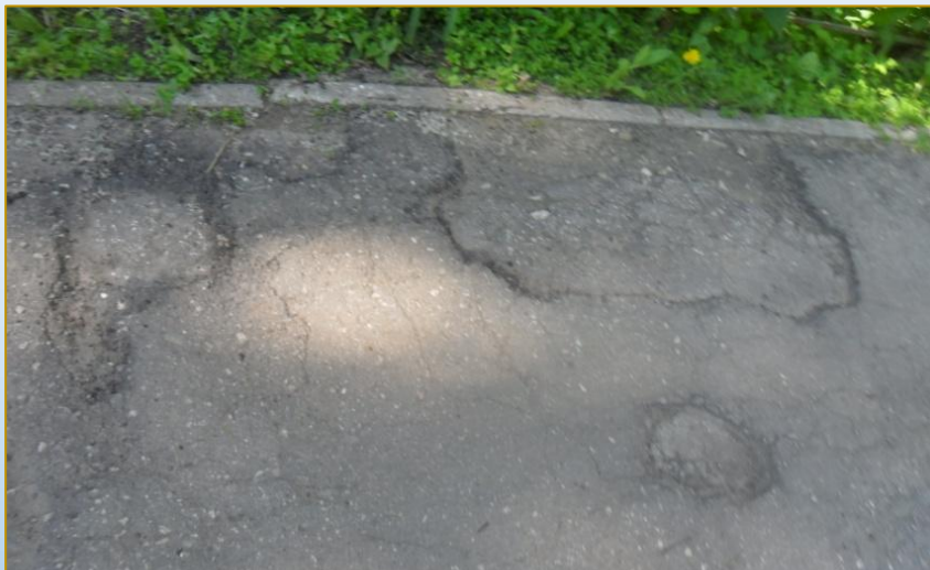
Фото объекта «До»
