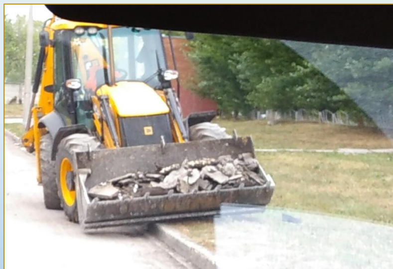
Фото объекта «В работе»
