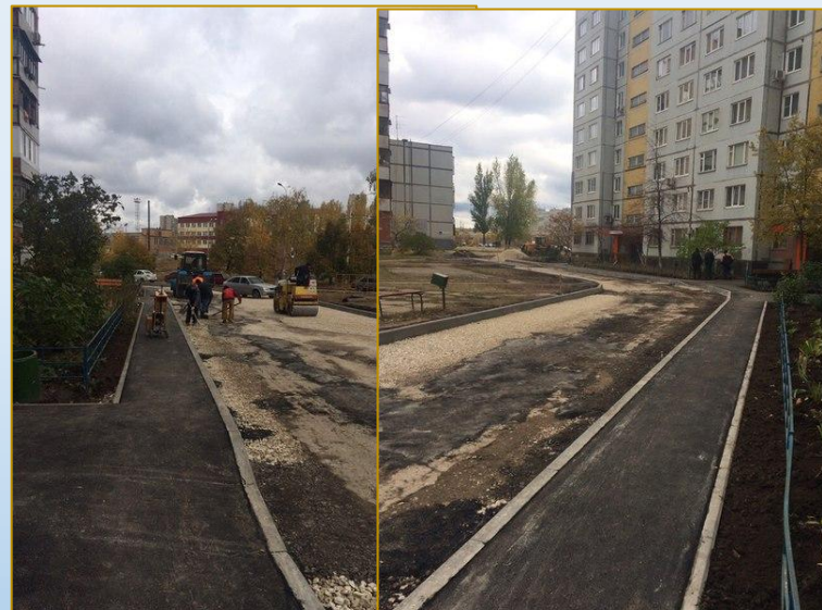
Фото объекта «В работе»
