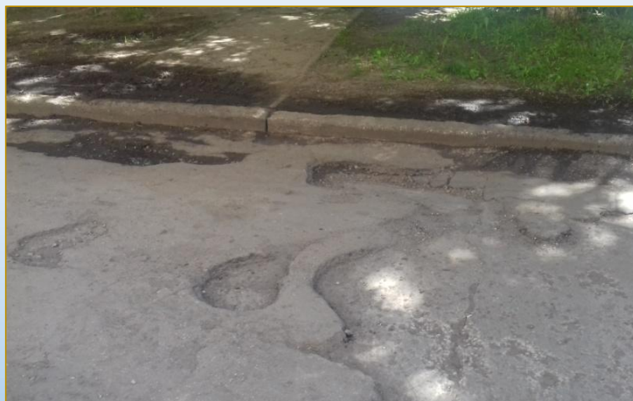
Фото объекта «До»
