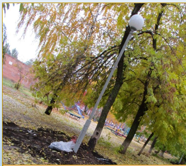
Фото объекта «В работе»
