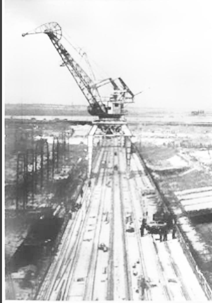
Начало строительства. Погрузочная эстакада
