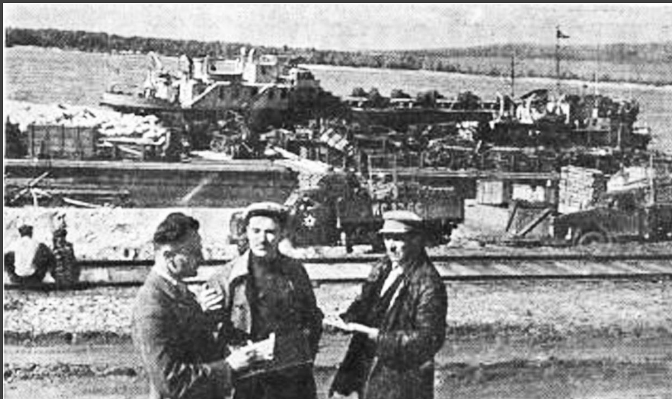
Причал Куйбышевгидростроя. Разгрузка оборудования для Куйбышевской ГЭС
