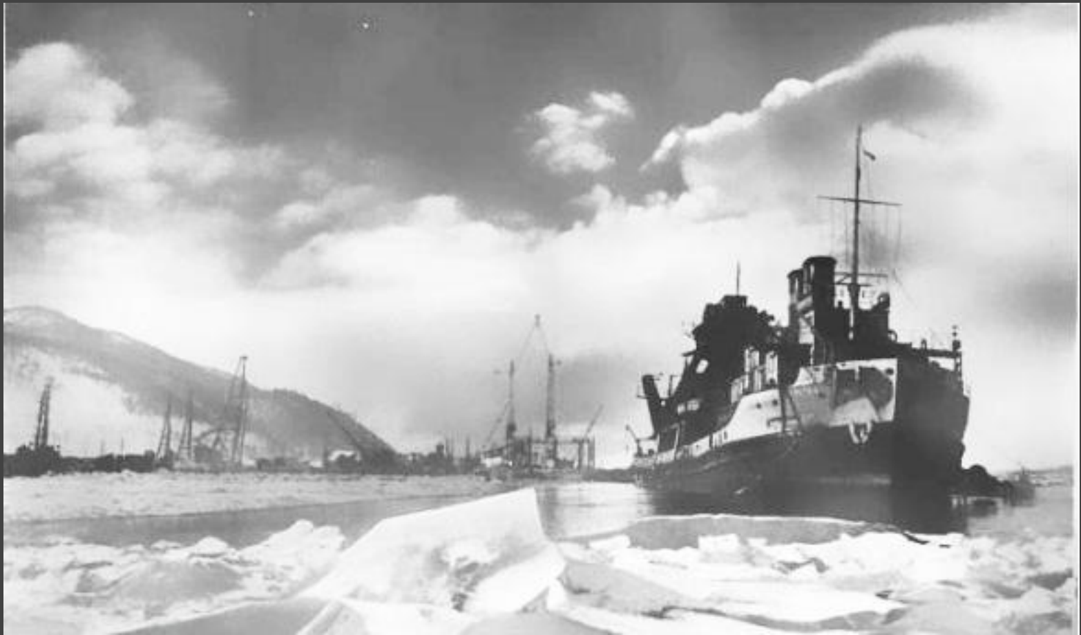
Землечерпалка «Пятилетка» на верховой перемычке
