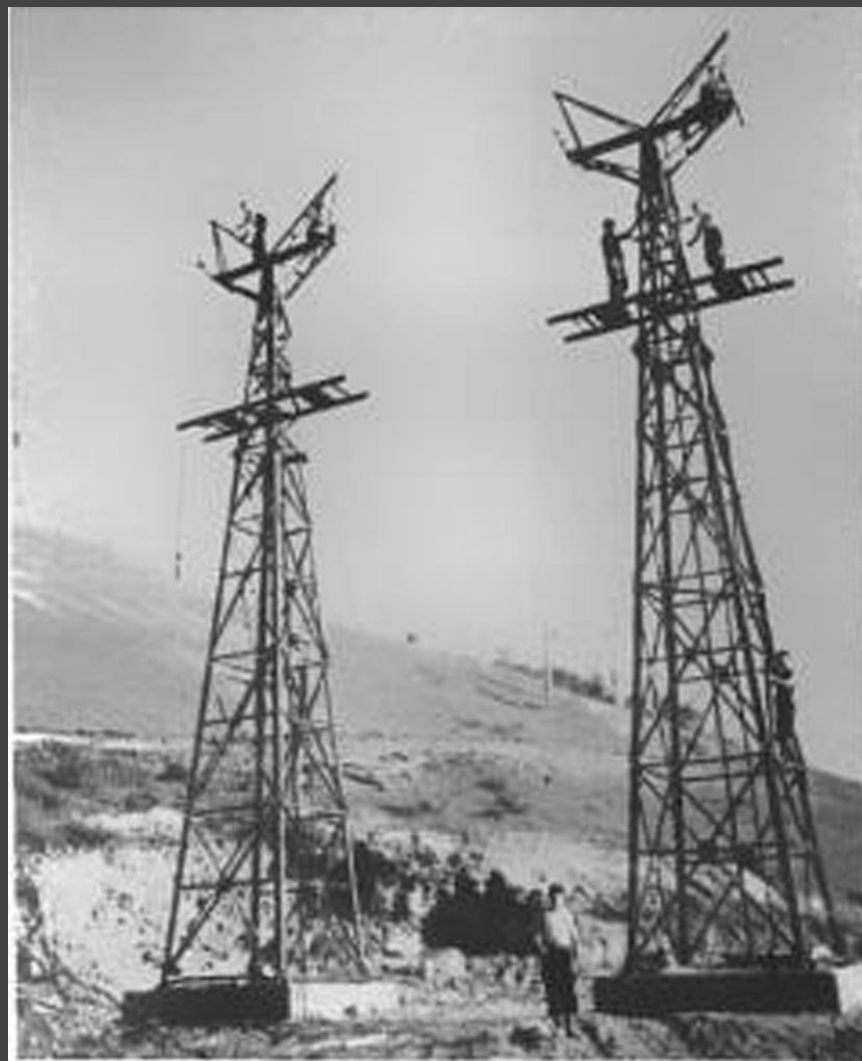
Установка металлических опор у горы Могутовой
