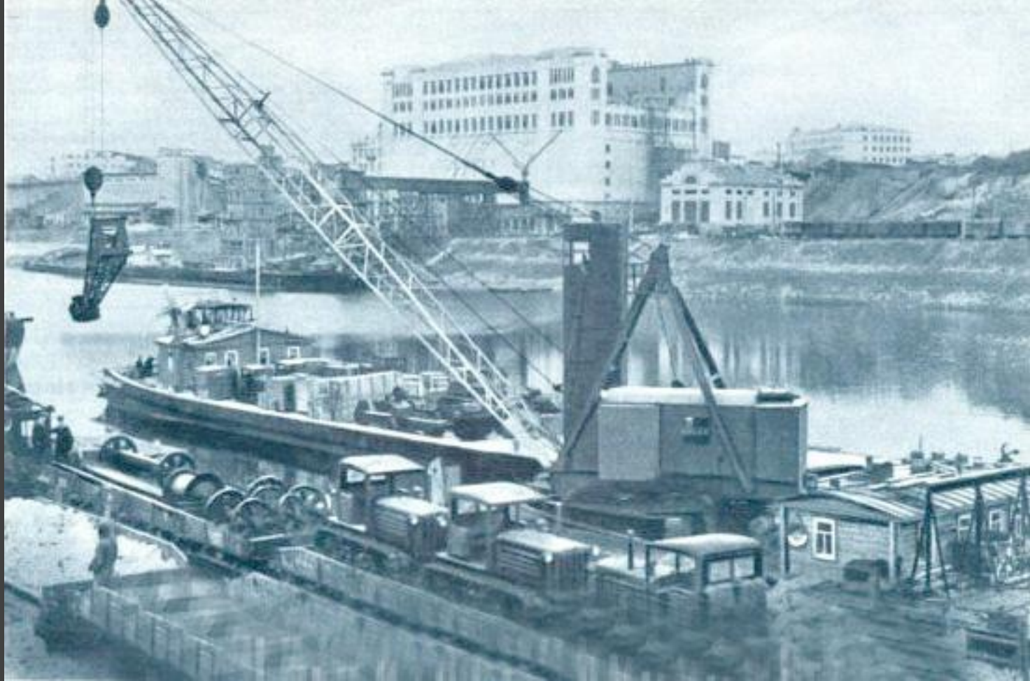
Сормовская землечерпалка, работавшая на подготовке ложа Куйбышевского водохранилища
