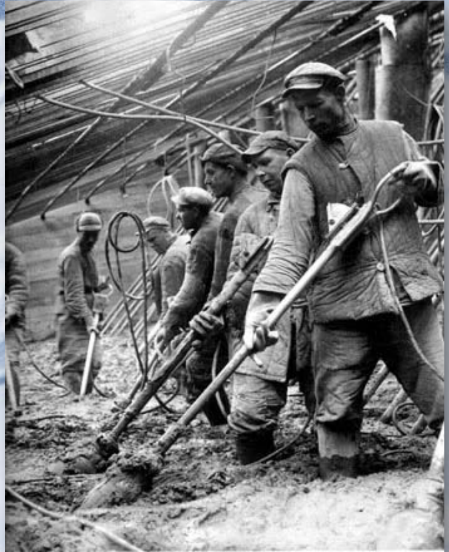
Укладка бетона на строительстве Красноглинской ГЭС.
